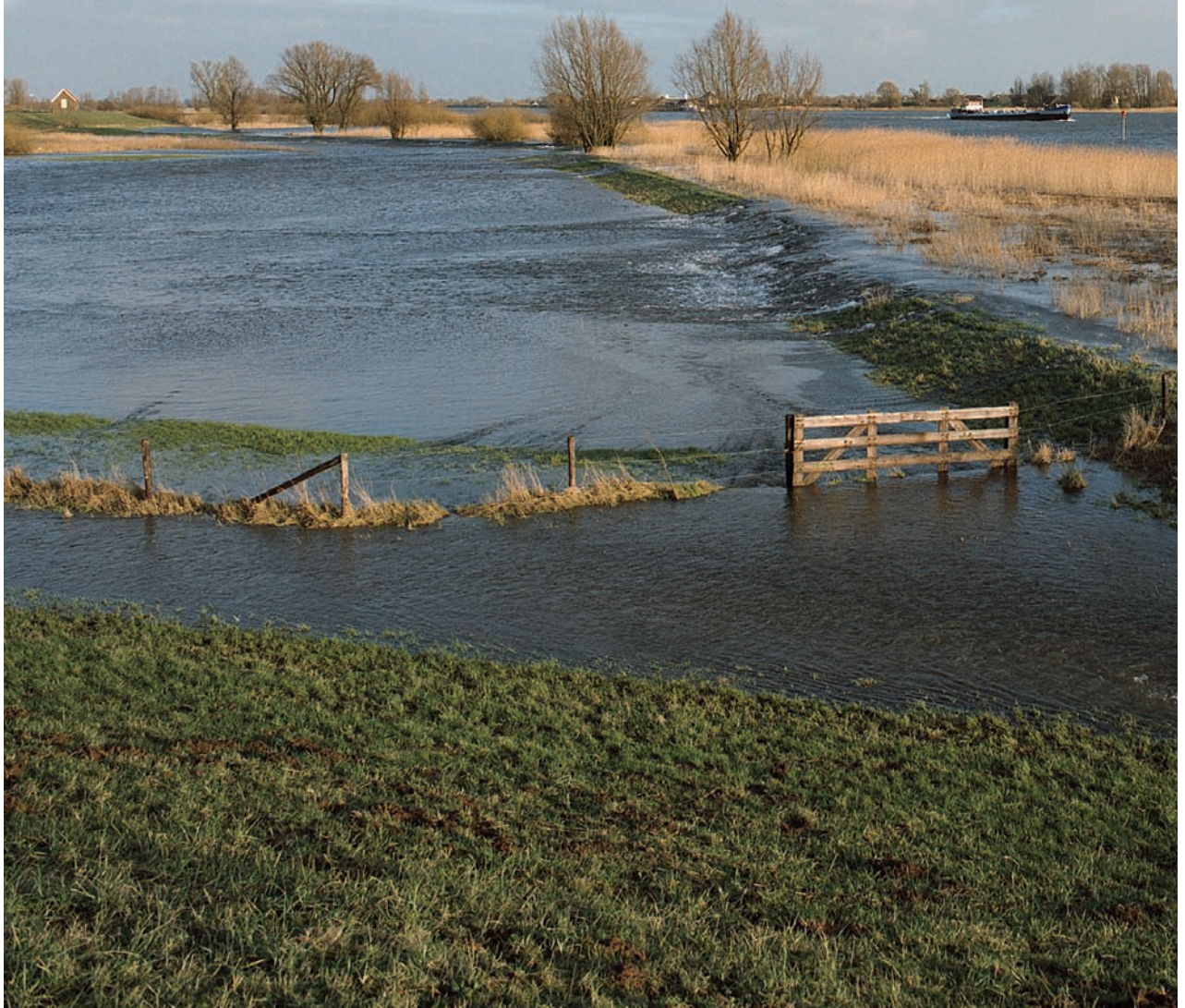
Het overstroom van een zomerdijk in een uiterwaard langs de Lek nabij Schoonhoven
