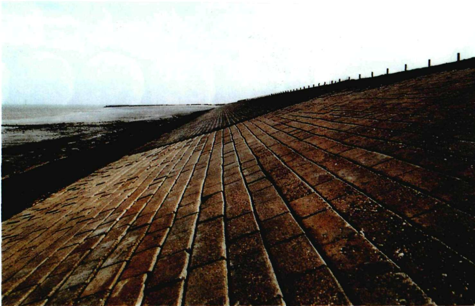
Foto 2.8 Gekantelde betonblokken
