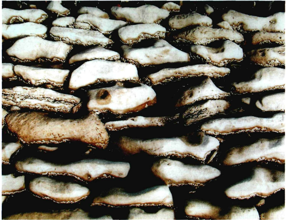
Foto 1.3 Oude bekleding van Vilvoordse steen
