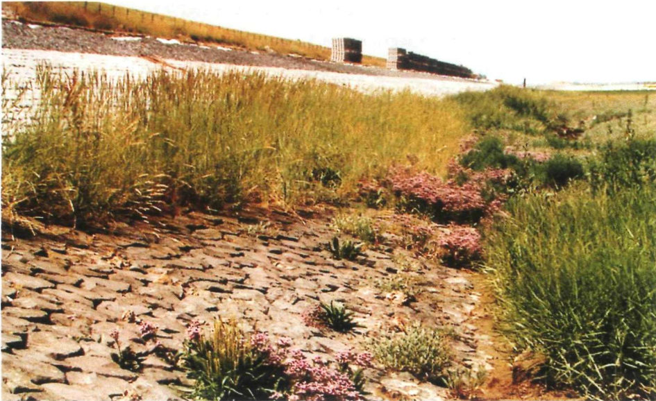
Foto 1.1 Begroeiing op bekleding van gebakken steen
