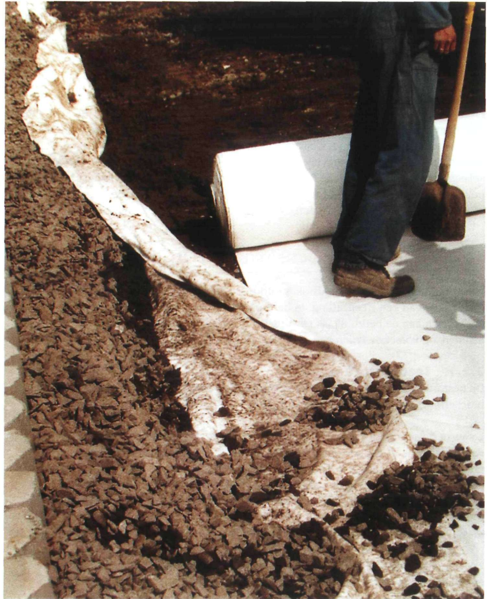
Foto 2.14 Geokunststof op de rol tijdens aanbrengen
