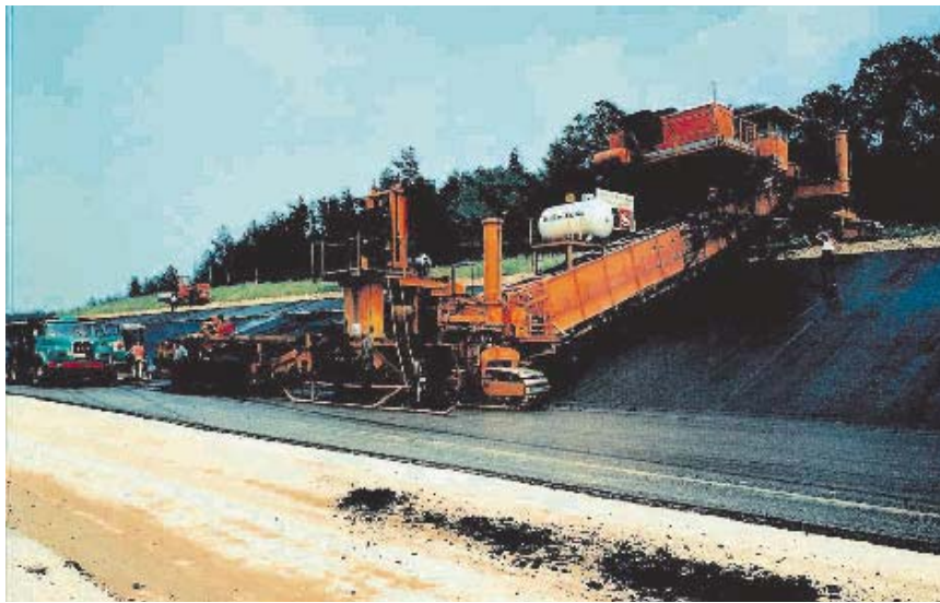
Figuur 8.10 Taludmachine (totaalprofiel) (Foto: Shell, 1999)
