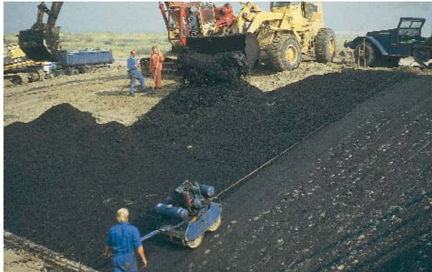
Figuur 8.8 Verwerken van waterbouwasfaltbeton met een shovel
