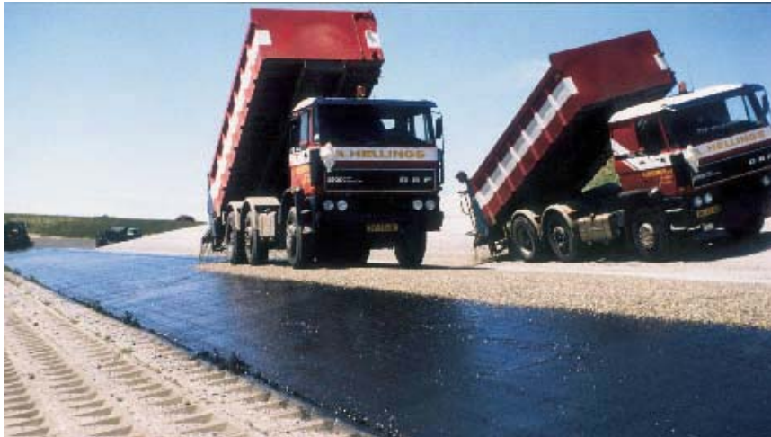
Figuur 8.31 Afstrooien met split voor het aanbrengen van een oppervlakbehandeling (Foto: ESHA)
