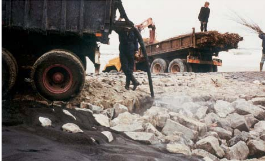
Figuur 8.19 Penetratie van gietasfalt met een roerketel - vol en zat
