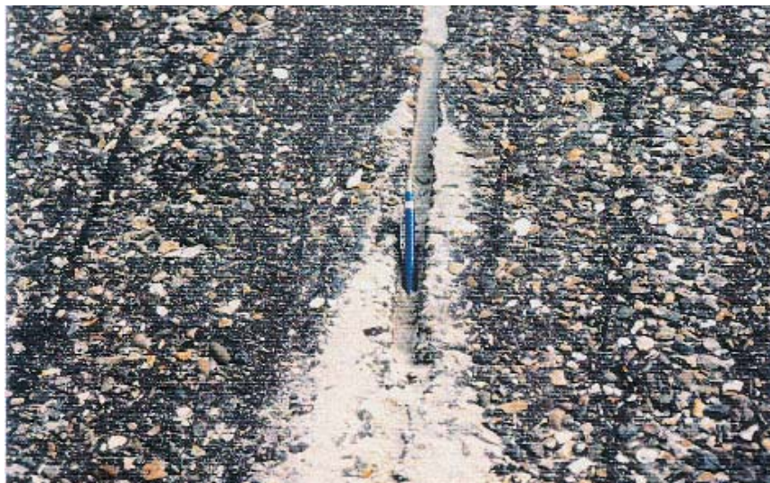
Figuur 9.5 Openstaande naad in een bekleding van waterbouwasfaltbeton - Damaanzet Schouwen (Foto: Oranjewoud)
