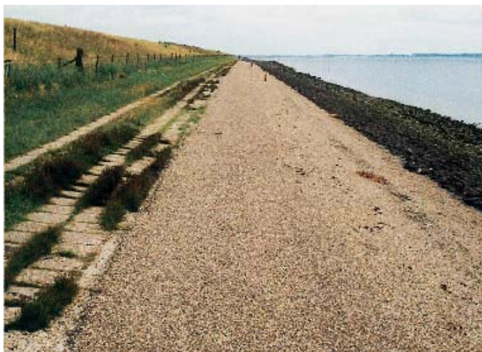
Figuur 3.1 Zeedijk met een bekleding van waterbouwasfaltbeton - Ouwerkerk - 1996 (Foto: Oranjewoud)
