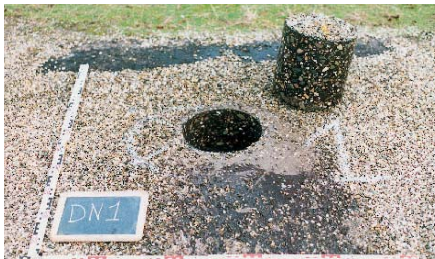
Figuur 2.13 Boorkern uit een bekleding van waterbouwasfaltbeton - Damaanzet Noordland - 1991 (Foto: NPC)
