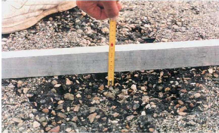
Figuur 9.6 Aangetast oppervlak bij een bekleding van waterbouwasfaltbeton - Boulevard De Ruyter in Vlissingen - 1994 (Foto: Oranjewoud)
