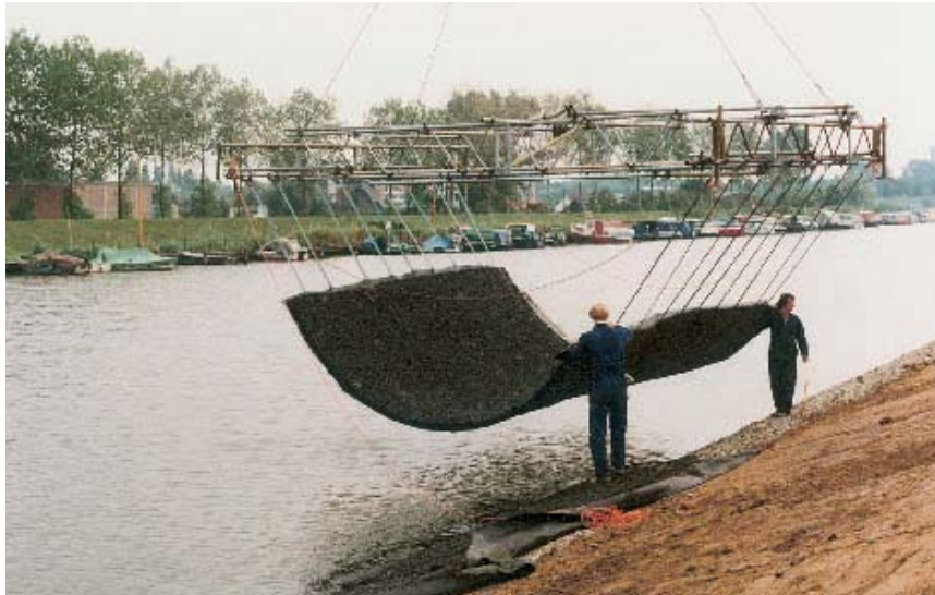
Figuur 8.24 Plaatsen van een mat van open steenasfalt met behulp van een hijsframe - Kanaal van Steenenhoek - 1982 (Foto: Bitumarin)
