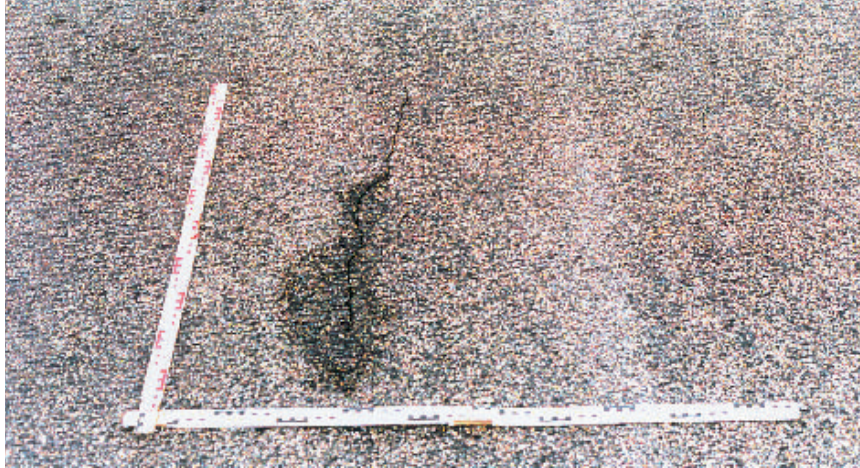
Figuur 9.4 Scheur in een bekleding van waterbouwasfaltbeton - Boulevard De Ruyter in Vlissingen - 1991 (Foto: Oranjewoud)
