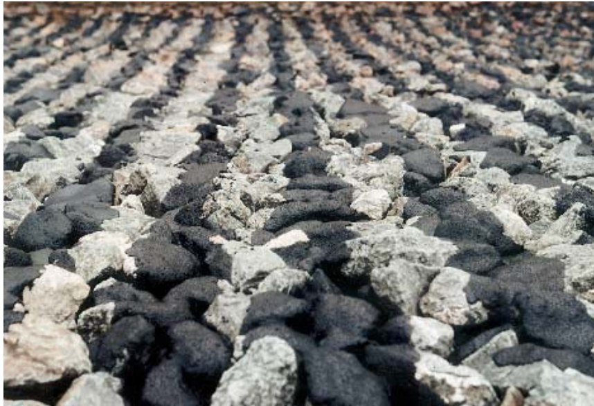
Figuur B7.1 Strokenpenetratie (Foto: Bitumarin)
