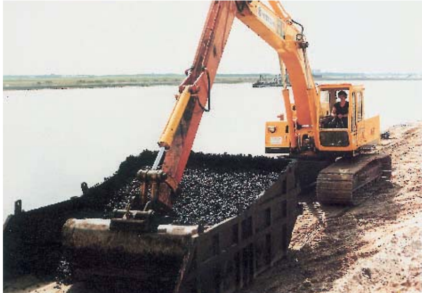
Figuur 8.7 Inrijbak als tussenopslag bij de verwerking van asfalt met een hydraulische kraan (Foto: Bitumarin)
