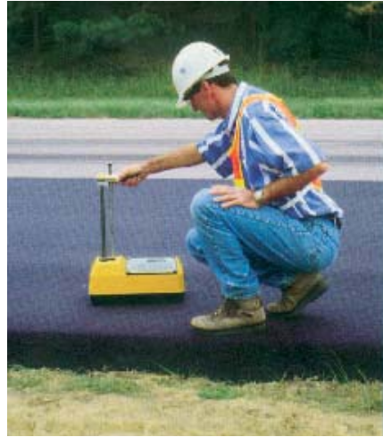
Figuur 9.7 Nucleaire dichtheidsmeter op een asfaltverharding (Foto: NPC)
