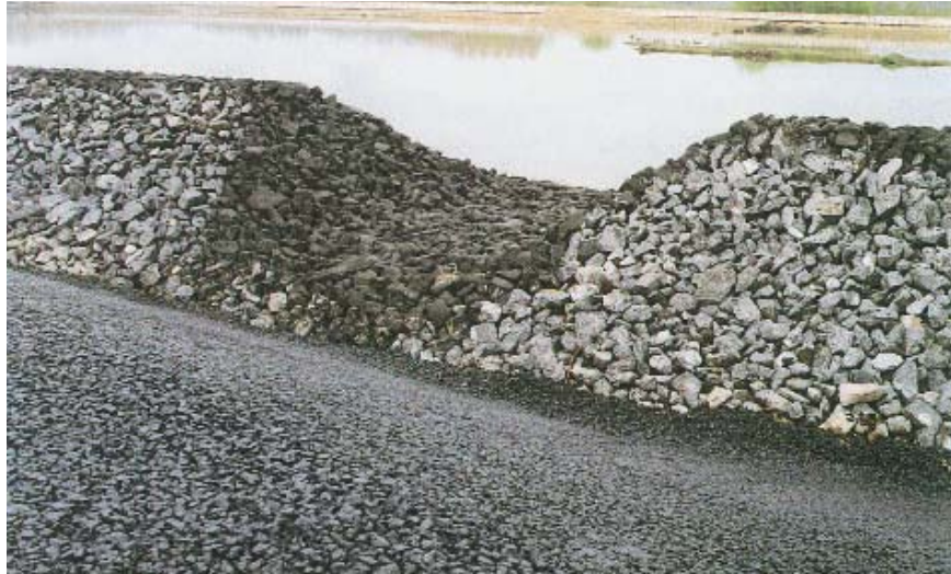
Figuur 3.4 Vooroeververdediging direct na aanleg - Zeekanaal Brussel-Schelde in België (Foto: Bitumarin)
