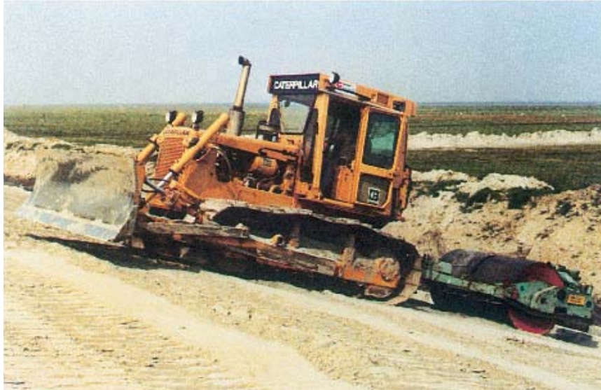
Figuur 8.2 Verdichten van het zandbed met een trilrol
