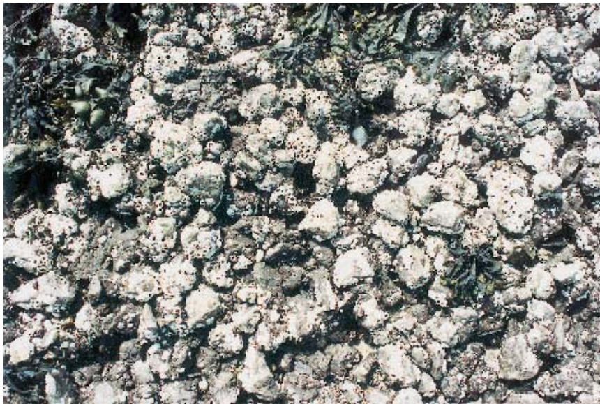
Figuur 2.5 Biologische aantasting van open steenasfalt door zeepokken - Neeltje Jans - 1989 (Foto: Oranjewoud)
