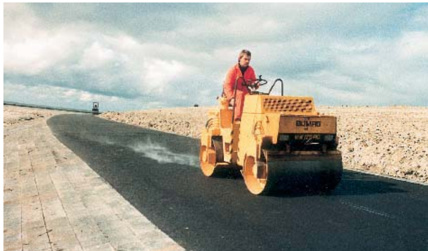
Figuur 7.21 Aanleg onderhoudsweg op berm - Ameland - 1987
