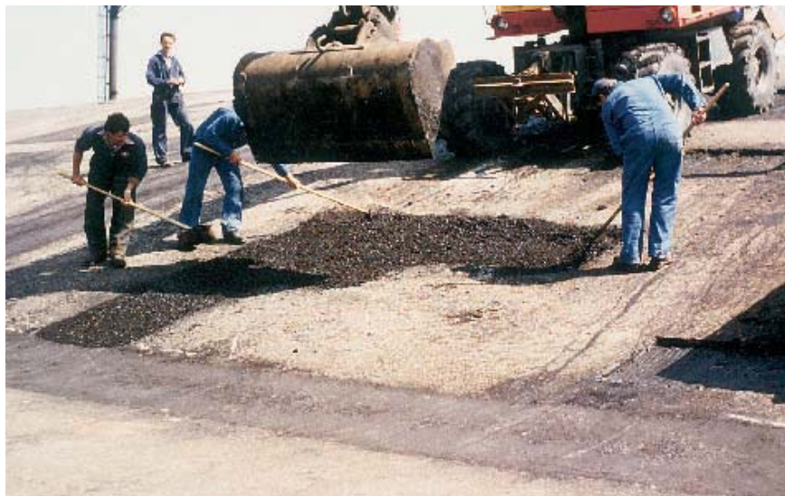
Figuur 9.16 Uitvullen van een gefreesde bekleding met waterbouwasfaltbeton - Roggeplaat - 1986
