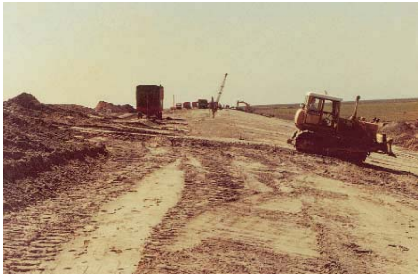
Figuur 8.1 Profileren van het zandbed - Sjoukeshoek - 1983
