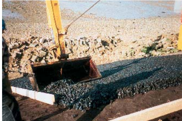
Figuur 8.23 Aanbrengen van een daglas van open steenasfalt op een filter van zandasfalt (Foto: Bitumarin)
