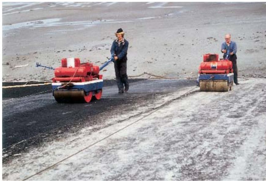
Figuur 8.14 Verdichten van waterbouwasfaltbeton - hoofdverdichting - Emmapolder - 1982
