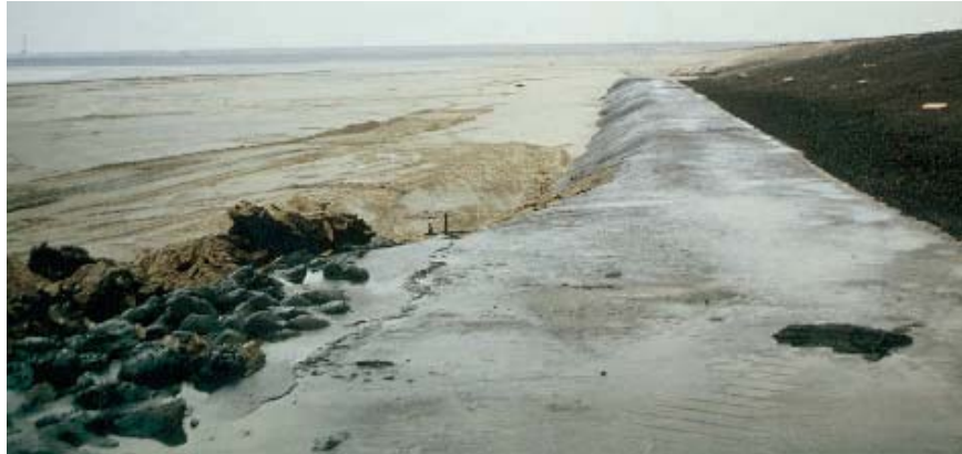
Figuur 7.18 Asfaltmastiexslab als bescherming van de teen van de dijk tegen ontgronding - Veersedam
