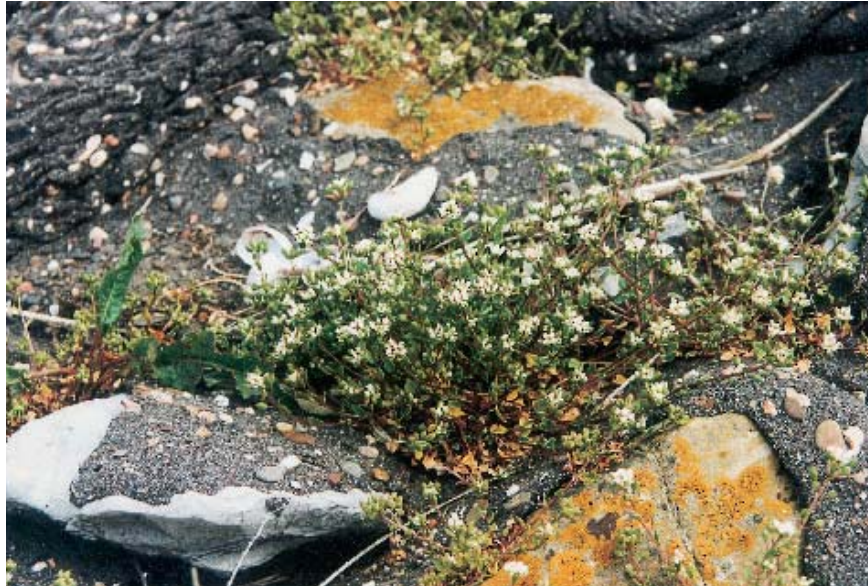
Figuur 6.9 Oude gietasfaltpenetratie met begroeiing - Grevelingendam - 1996
