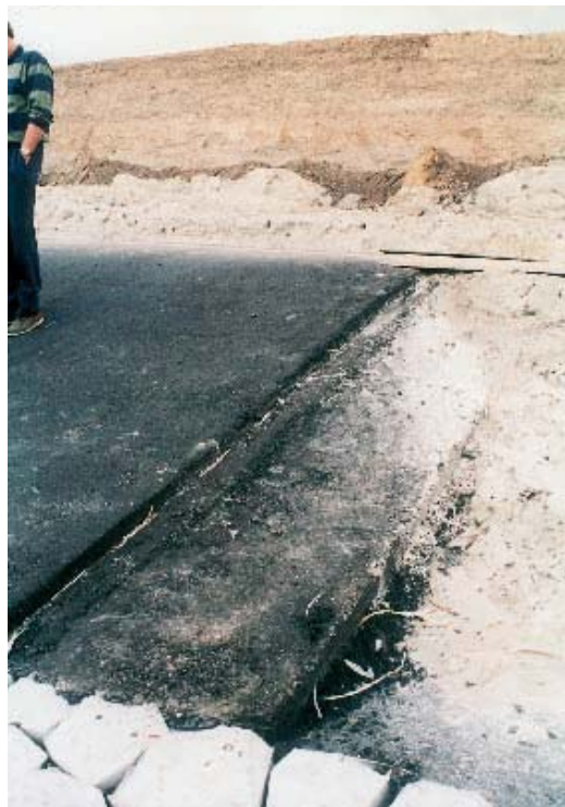
Figuur 8.17 Daglas in waterbouwasfaltbeton uitgevoerd als schuine liplas - Texel - 1998 (Foto: NPC)
