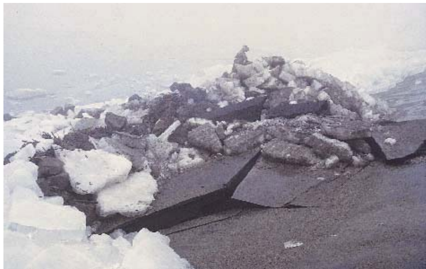
Figuur 7.19 Schade aan een asfaltbekleding door kruierend ijs - Houtribdijk
