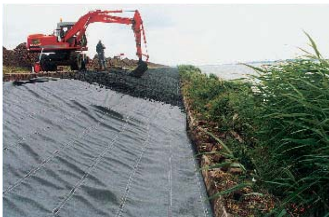
Figuur 8.22 Aanbrengen van open steenasfalt in situ - Eemmeer - 1993
