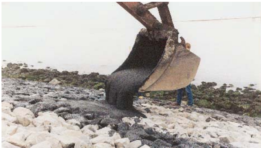
Figuur 8.20 Penetratie van gietasfalt met de bak van een hydraulische kraan
