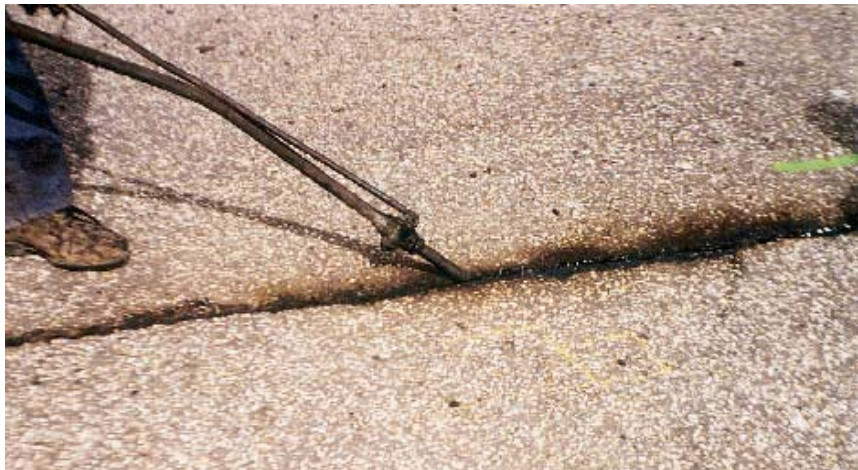
Figuur 9.12 Vullen van scheur met bindmiddel - Roggeplaat - 1986
