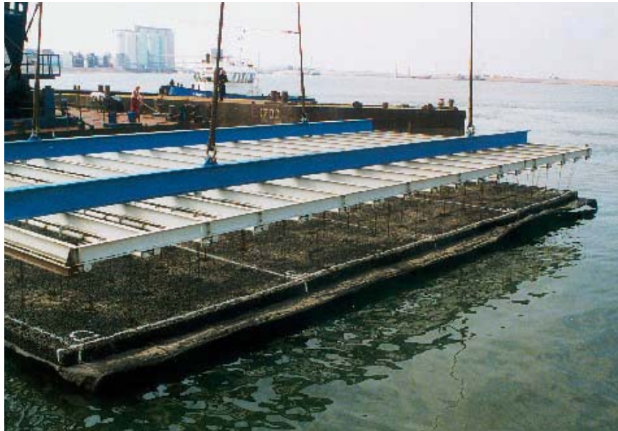
Figuur 8.25 Plaatsen van een grote mat van open steenasfalt met een hijsframe - Rotterdam - 1998 (Foto: Bitumarin)
