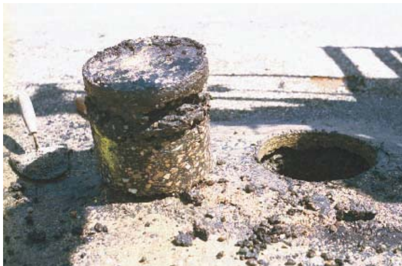
Figuur 9.2 Kwaliteitsindicator - Boorkern met slechte samenhang uit 40 jaar oude bekleding met hoge holle ruimte - Boulevard De Ruyter in Vlissingen (Foto: NPC)
