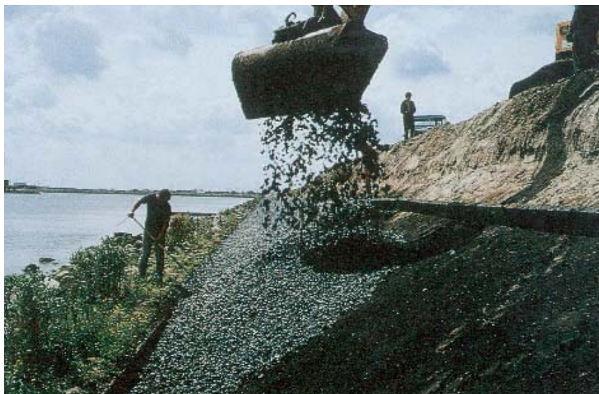
Figuur 3.6 Filter van zandasfalt waarop open steenasfalt wordt aangebracht - Hartelkanaal (Foto: Bitumarin)
