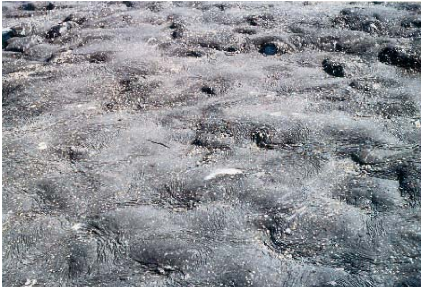
Figuur 8.21 Penetratie van gietasfalt - "te vol en zat"
