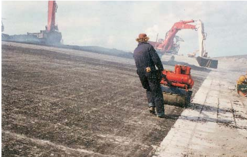
Figuur 8.15 Verdichten van waterbouwasfaltbeton - naverdichting - Emmapolder - 1982
