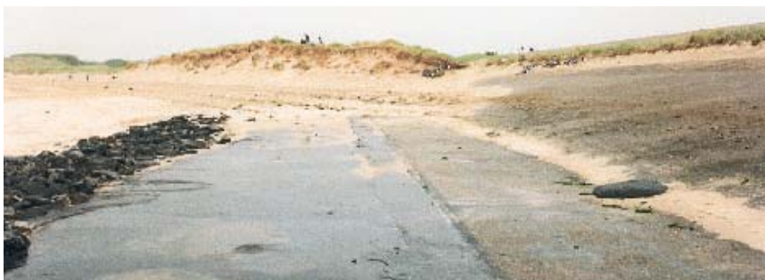
Figuur 3.2 Teenbescherming van gietasfalt - Veersedam - 1991 (Foto: Oranjewoud)
