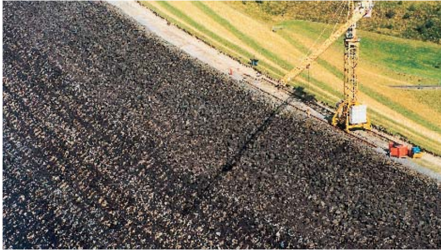
Figuur 7.16 Breuksteenbekleding met patroonpenetratie van gietasfalt - Megget Dam in Schotland (Foto: Bitumarin)
