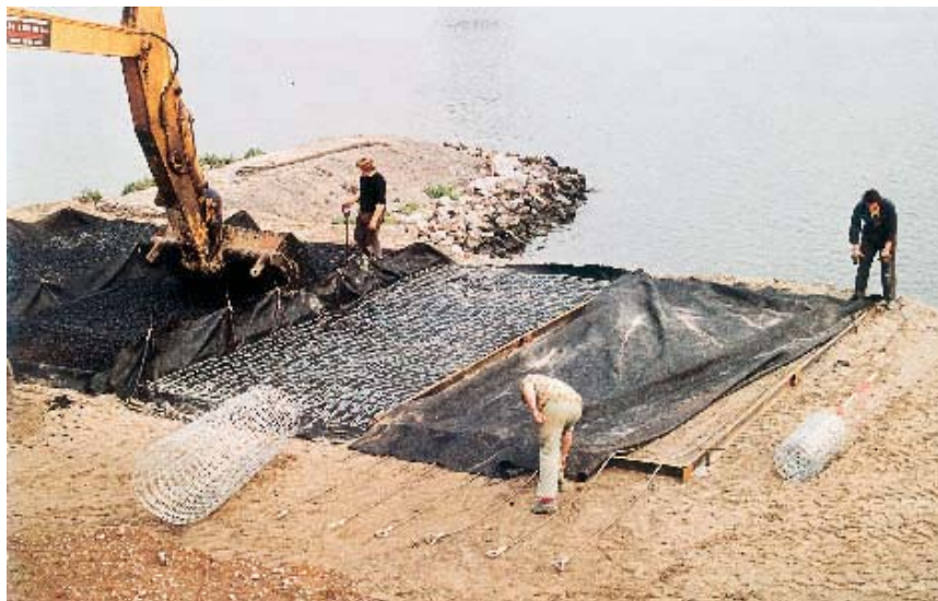
Figuur 7.44 Aanbrengen van wapening in een mat van open steenasfalt (Foto: Bitumarin)
