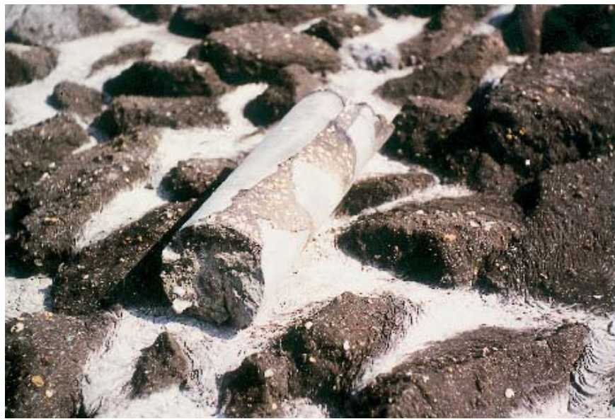
Figuur 2.15 Boorkern uit een bekleding van vol en zat gepenetreerde breuksteen - Westkapelse zeedijk - 1988
