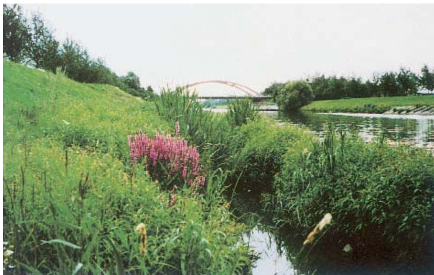
Figuur 3.5 Begroeide vooroeververdediging - Zeekanaal Brussel-Schelde in België (Foto: Bitumarin)
