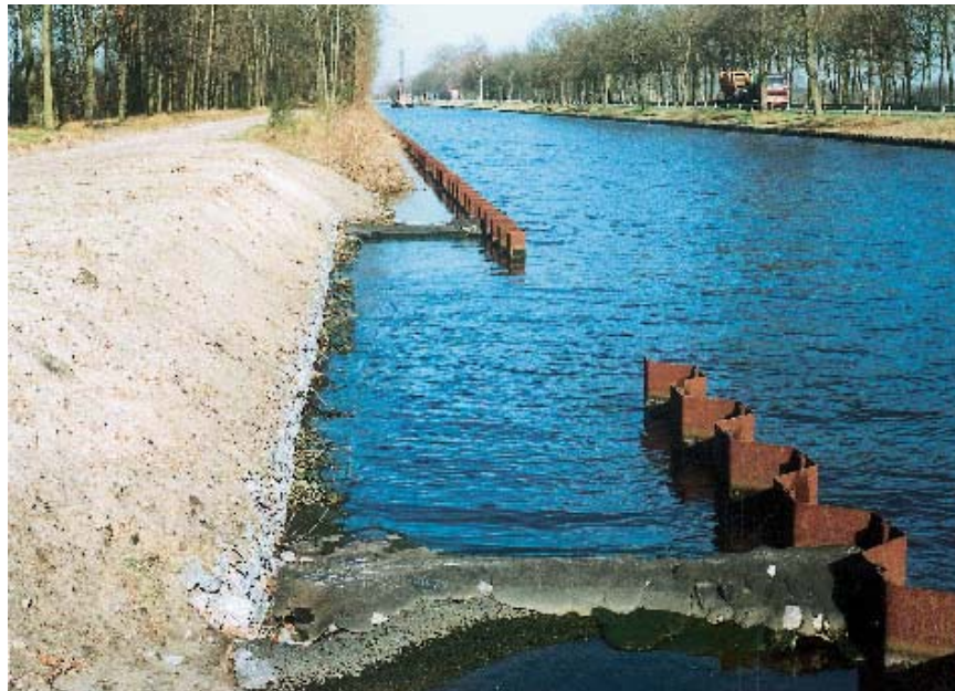
Figuur 6.3 Fauna-uitstapplaats, met de zijkanten uitgevoerd in asfalt (Foto: Bitumarin)
