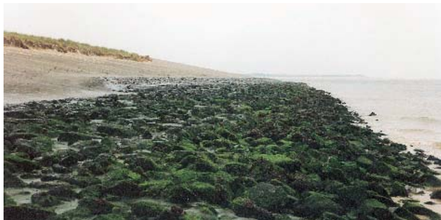
Figuur 5.1 Bekleding van gepenetreerde breuksteen (onder) en waterbouwasfaltbeton (boven) om erosie van het zandlichaam te voorkomen - Veersedam (Foto: NPC)
