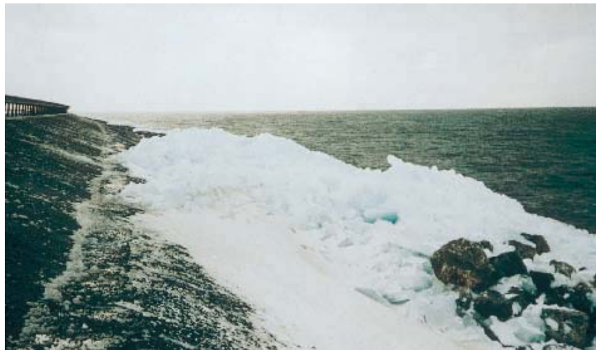
Figuur 6.2 Bekleding van open steenasfalt belast door kruiend ijs - Houtribdijk (Foto: Bitumarin)
