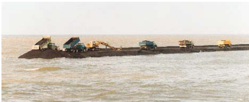
Figuur 8.26 Uitrijden van zandasfalt voor de bouw van een dam - Zeebrugge in België (Foto: Bitumarin)
