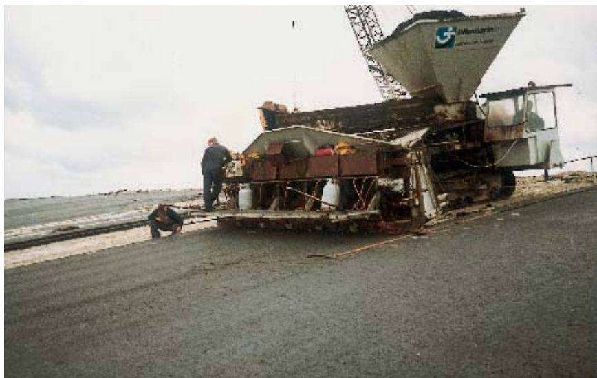
Figuur 8.12 Slipformpaver - Westkapelle - 1988
