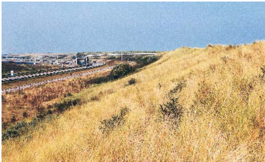
Figuur 6.8 Zandsuppletie met helm beplant op het binnentalud van de Veersedam - 2000 (Foto: NPC)
