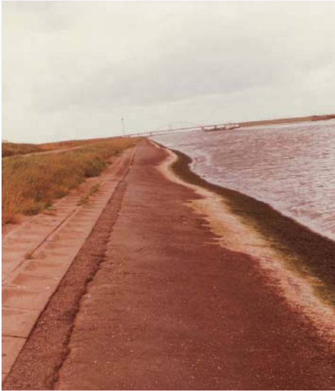
Figuur 6.1 Zetting van het dijklichaam op de plaats waar deze een oude sloot kruist - Schelde-Rijnkanaal - 1981
