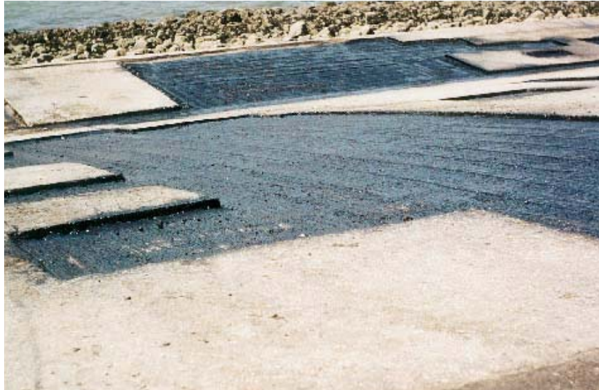
Figuur 9.15 Plaatselijk gefreesde bekleding - voor het uitvullen voorzien van een kleefmiddel - Roggeplaat - 1986
