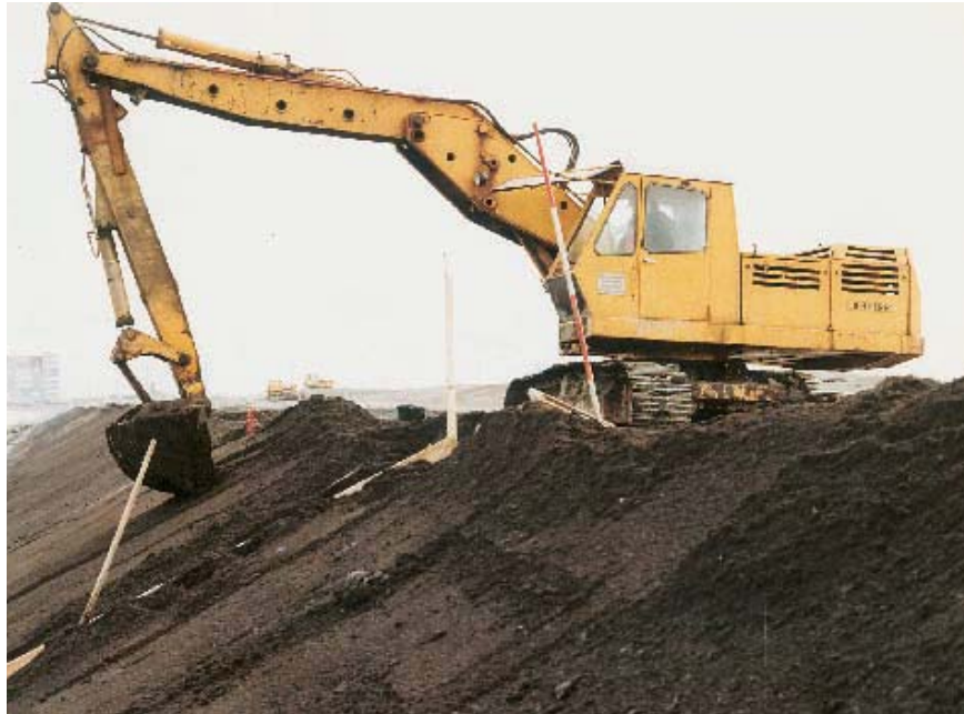
Figuur 8.27 Profileren van een zandasfaltdam - Zeebrugge in België (Foto: Bitumarin)
