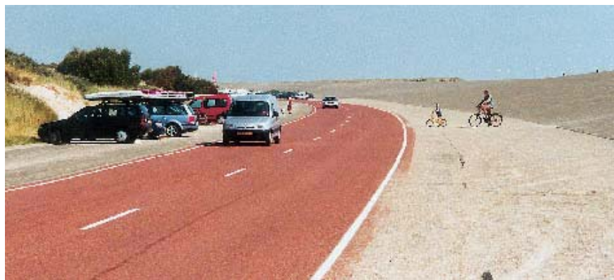
Figuur 6.5 Gekleurd asfalt op de Brouwersdam om de ligging van de rijweg te accentueren (Foto: NPC)
