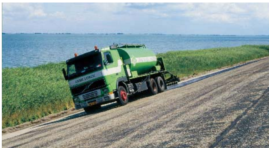
Figuur 8.30 Machinaal sproeien van bindmiddel voor het aanbrengen van een oppervlakbehandeling (Foto: ESHA)
