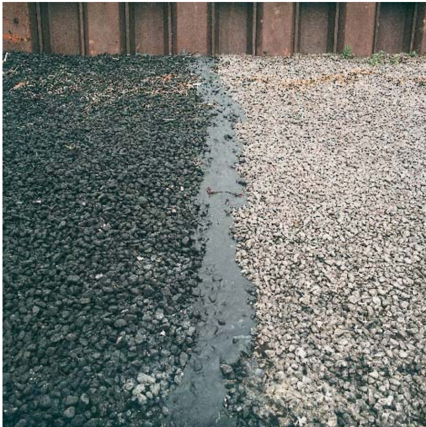
Figuur 7.24 Met asfaltmastiek afgegoten duurzame aansluiting bij open steenasfalt (Foto: Bitumarin)
