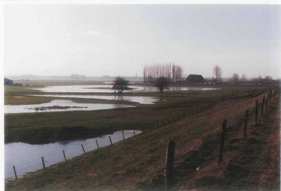
1.3b: Kleiafgraving direct aan binnendijk (Maasdijk te Velp, Noord-Brabant). Ter plaatse van de afgraving is verhoogde waakzaamheid geboden: piping kan hier pas in relatief gevorderd stadium worden opgemerkt. [RWS-DWW 322/18]
