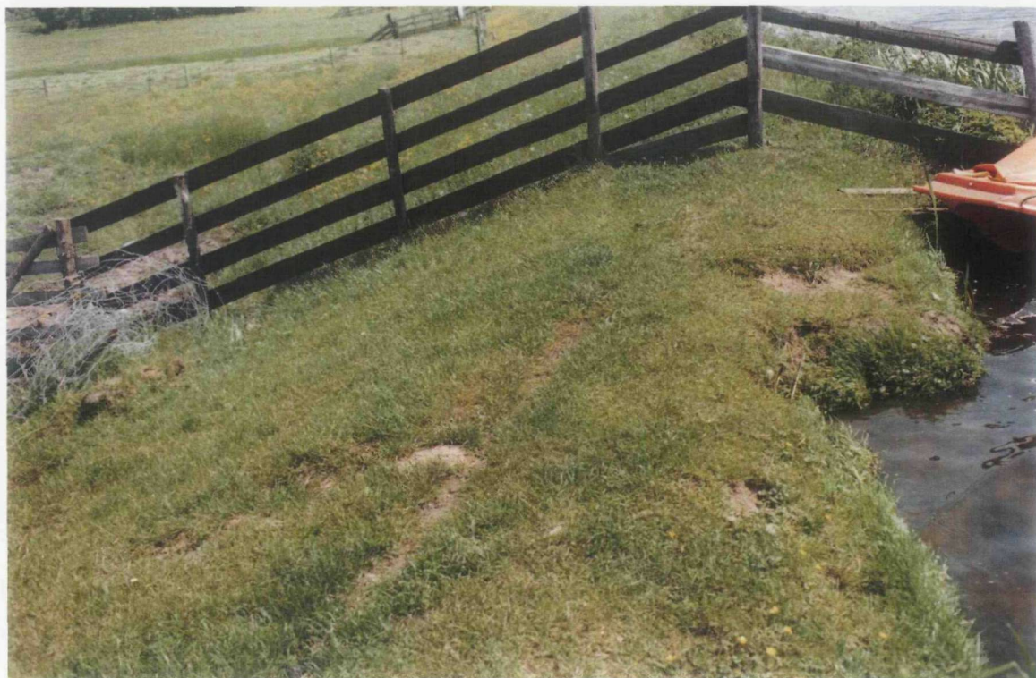
1.3 a: Afkalving van het buitentalud ter plaatse van een aardgasleiding, Kromme Does (boezemkade). [RWS-DWW 117/24a]
