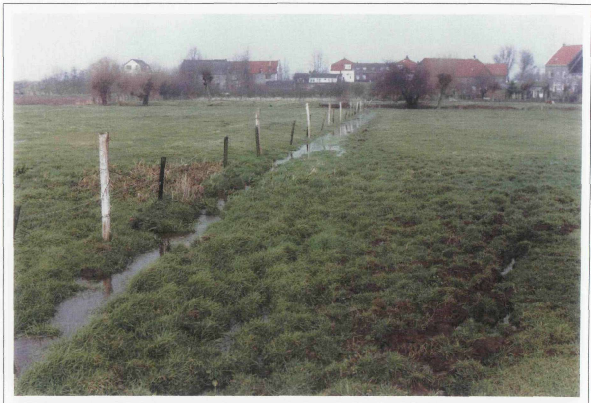
2.3a: Lokaal omhoog komen en verdrassing van het achterland achter de havendijk te Woudrichem, ter plaatse van een kopsloot. [RWS-DWW 128/1]
