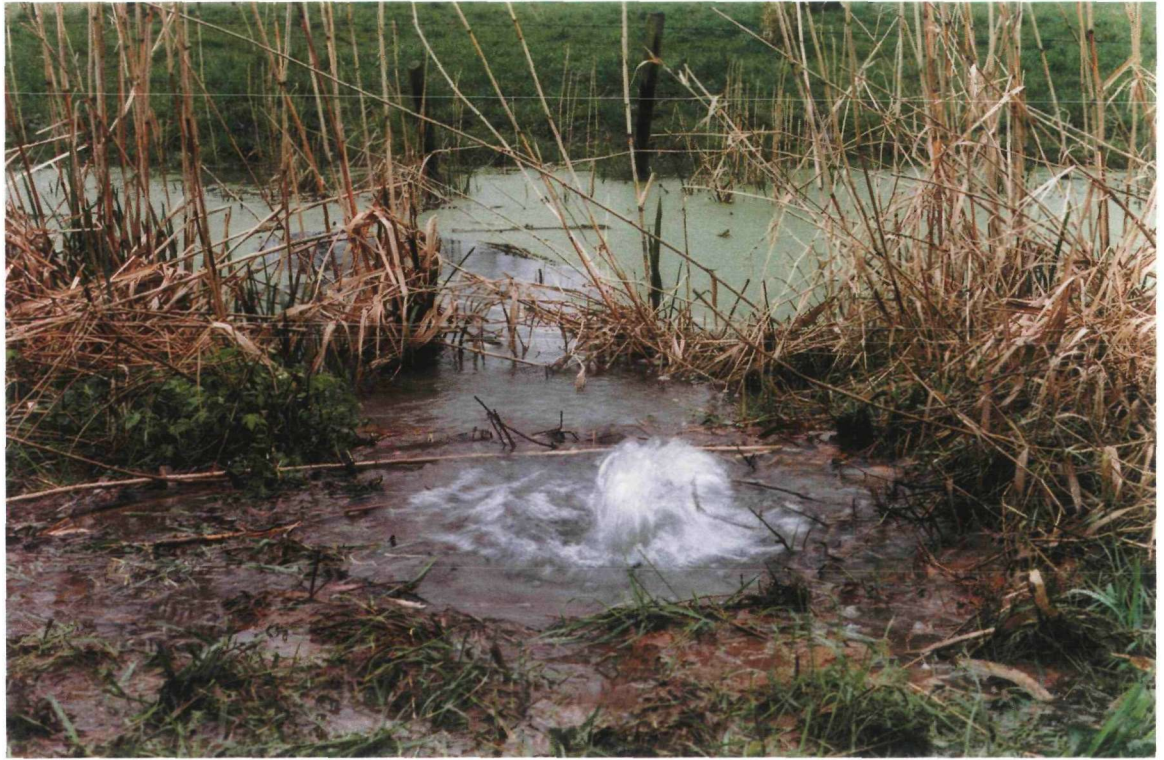
2.8: Schoon water spuit achter de dijk boven het maaiveld uit. Opvallend is dat dit vlak voor een sloot optreedt. Mogelijk is dit het gevolg van graverijen of een niet afgedicht boorgat. [RWS-DWW 470/20]
