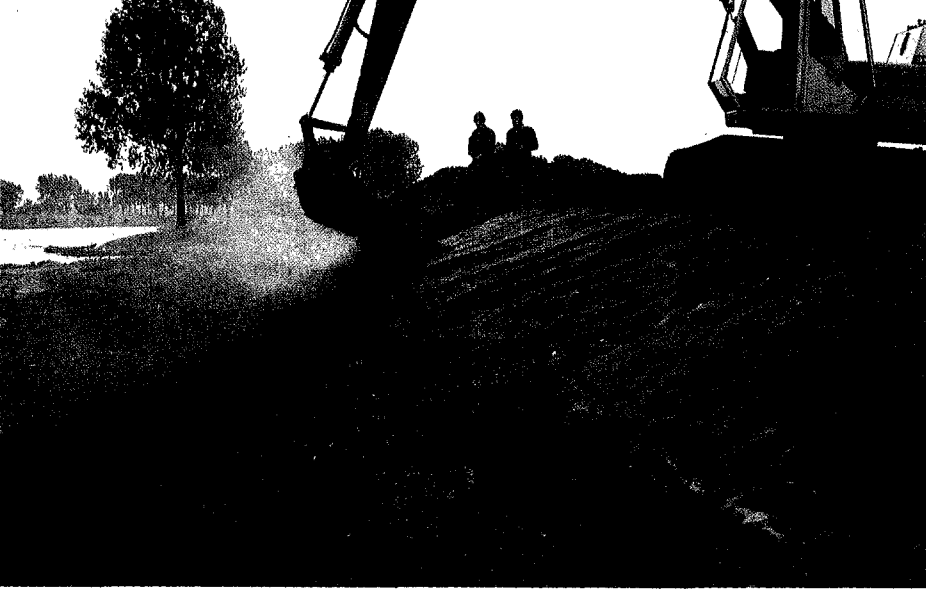
13 Aanbrengen van open steenasfalt op een filterdoek met een hydraulische kraan
