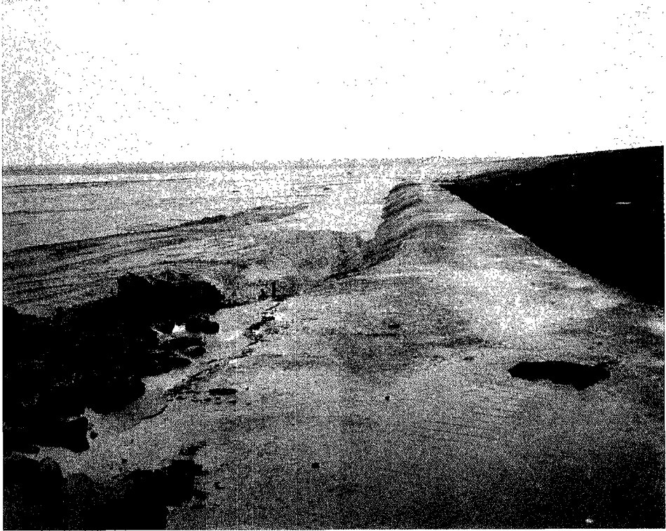
7 Een door een mastiekslab gevolgde ontgraving
