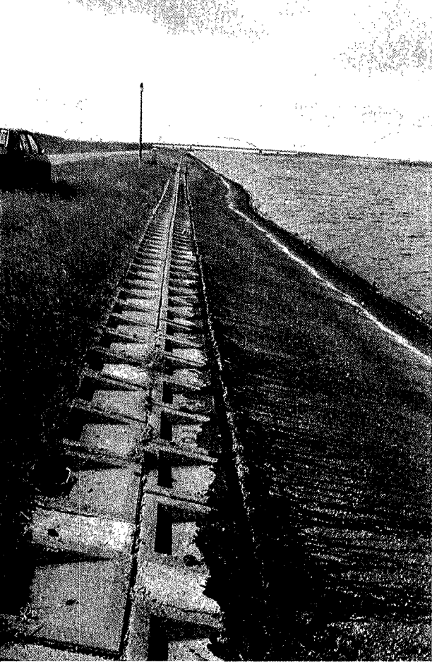
4 Vervorming van een asfaltbetonbekleding door een onregelmatige zetting van het dijklichaam
