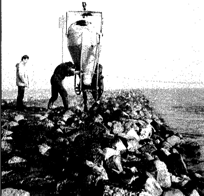
12 Penetrenen van een breuksteenlaag met een kubel
