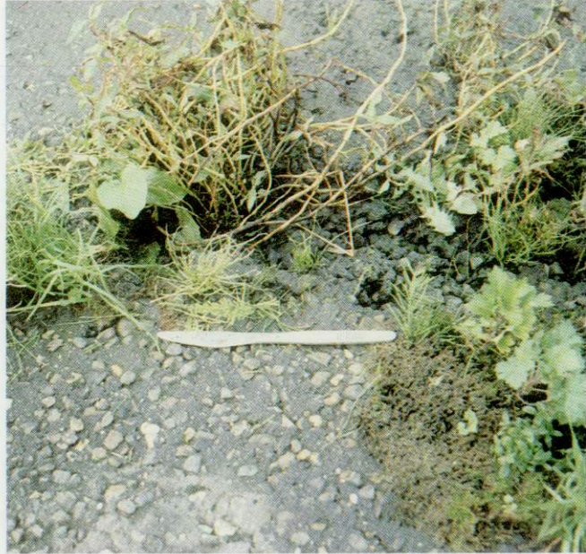
2 Aantasting van een asfaltbetonbekleding door plantengroei
