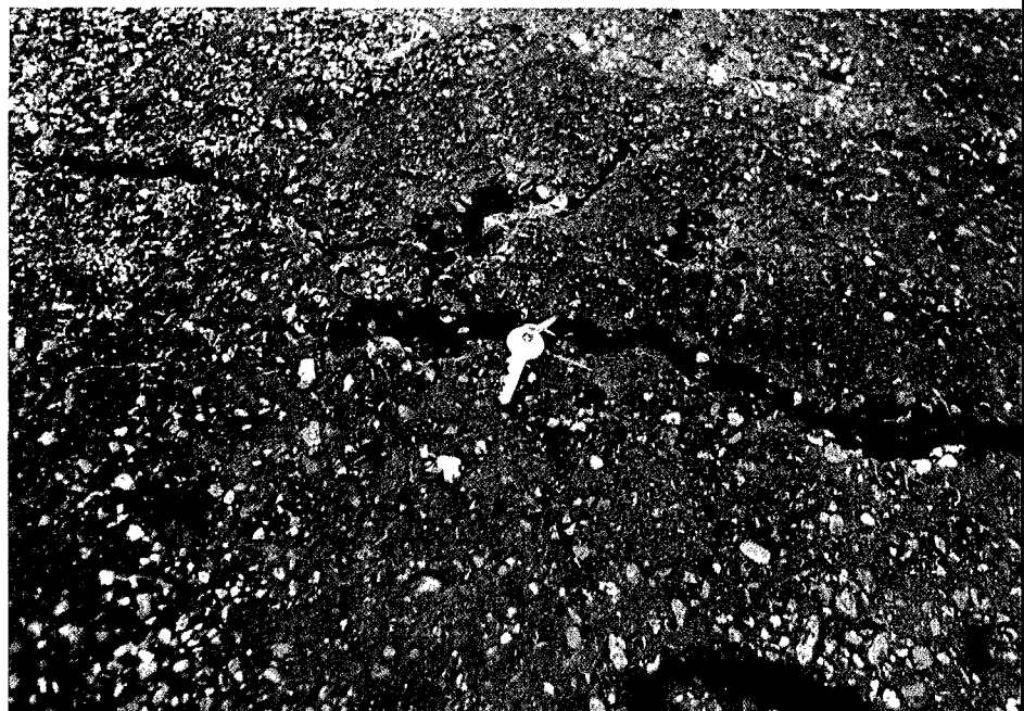
6 Detail van de schade ter plaatse van de zetting
