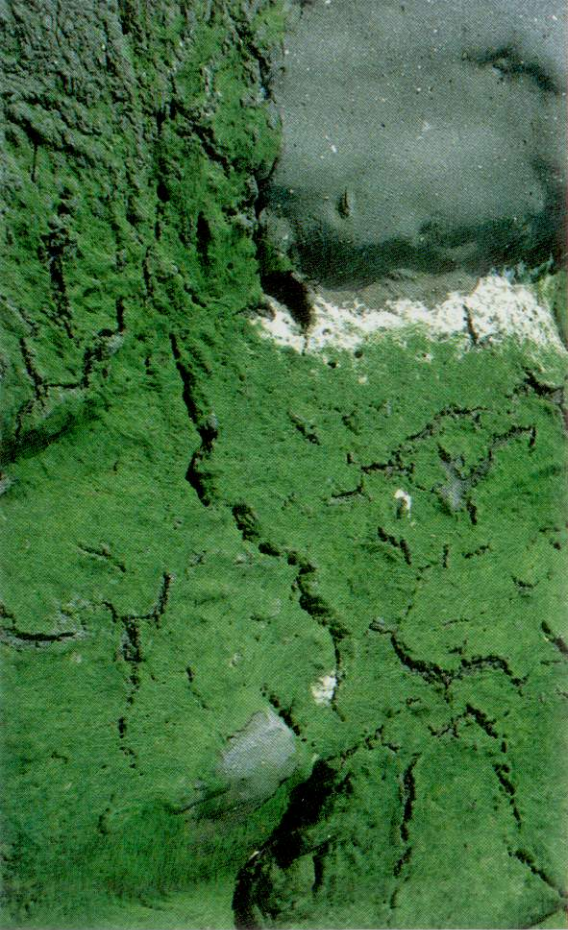
1 Aantasting van een asfaltbetonbekleding door algengroei
