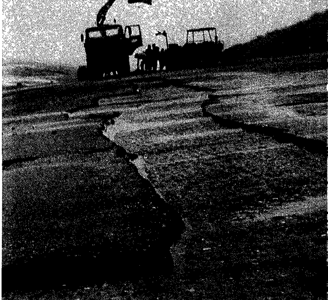
19 Reparatie van een ernstig aangetast oppervlak van een asfaltbetonbekleding de schadeplek is uitgefreesd
