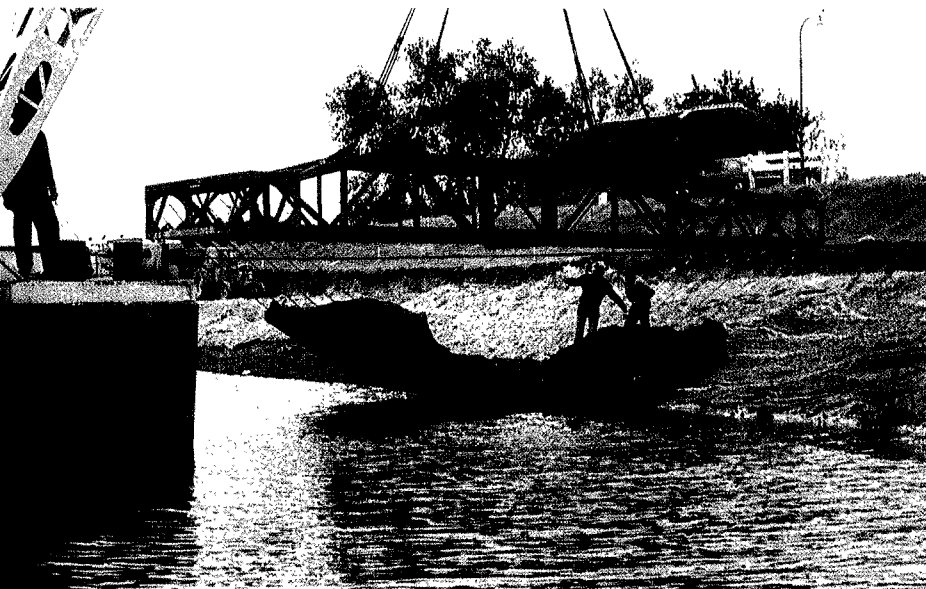
15 Aanbrengen van een open steenasfaltmat
