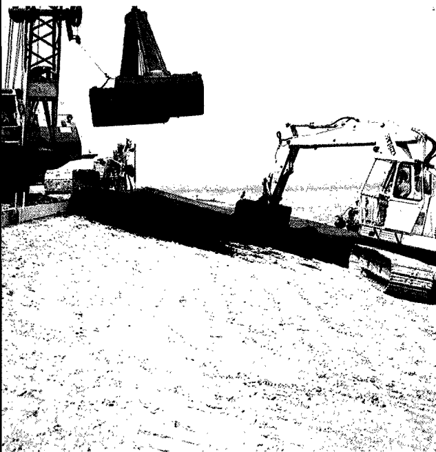
8 Aanbrengen van een asfaltbetonbekleding: de draadkraan deponeert het asfalt op het talud; de hydraulische kraan verspreidt het verder
