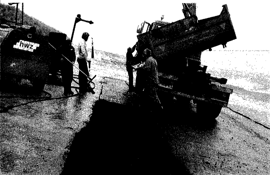
20 Reparatie van een ernstig aangetast oppervlak van een asfaltbetonbekleding: het uitgefreesde deel wordt opgevuld met asfaltbeton
