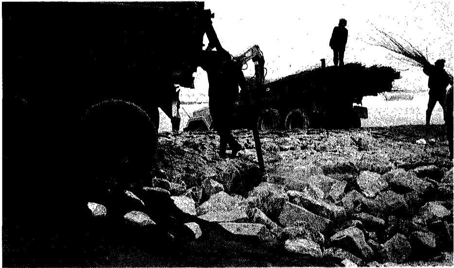
11 Penetrenen van een breuksteenlaag rechtstreeks uit het middel van vervoer
