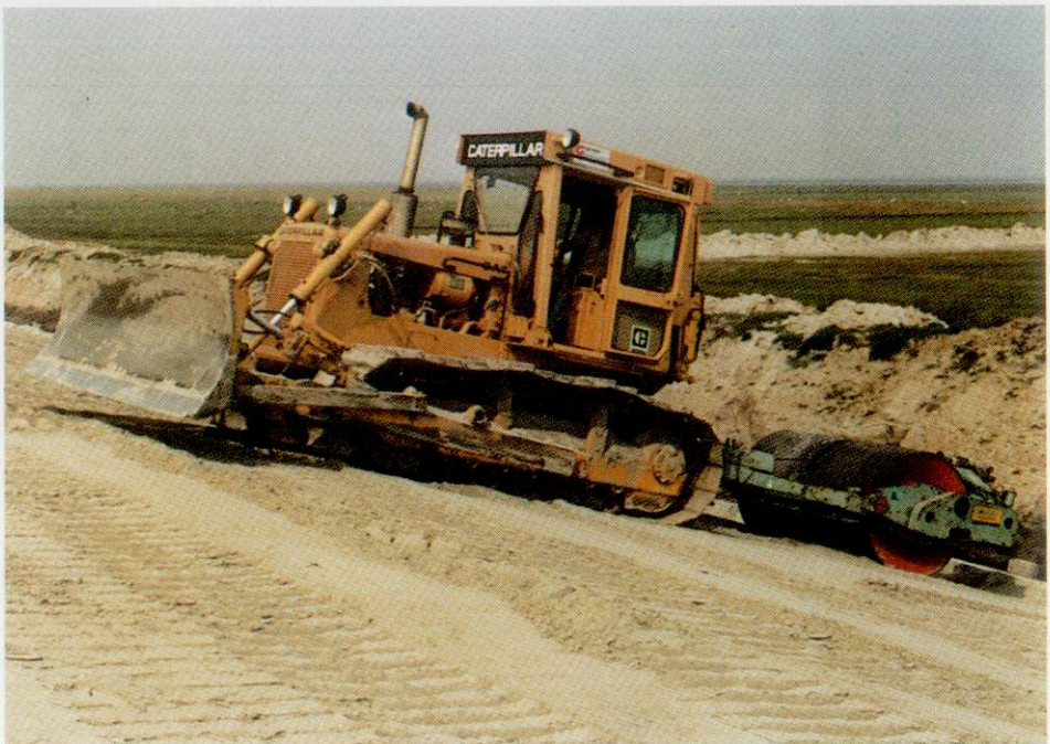
3 Verdichting van het zandbed met een trilrol
