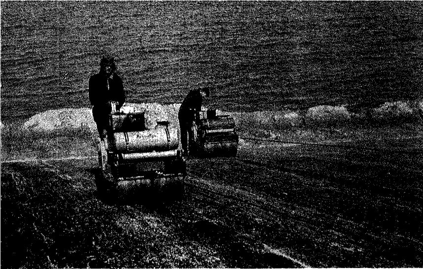
10 Verdichten van een asfaltbetonbekleding met de tandemtrilwals
