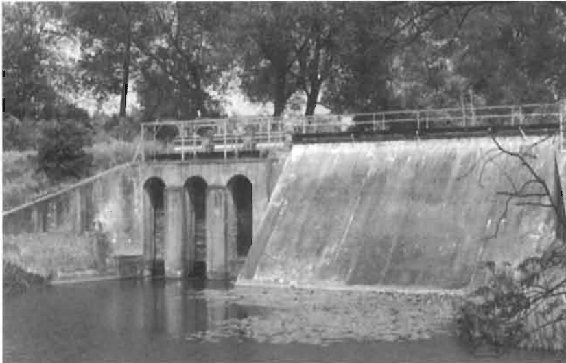
Inundatiesluis van een verdedigingswerk (Everdingen) in de waterkering bron: Heidemij, 1992 fotograaf: K. Blokker
