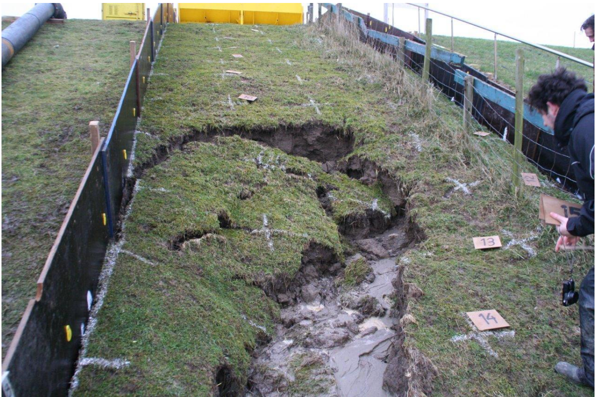
Figuur B91. Tholen. Sectie 3, afrastering. Bezweken talud.
