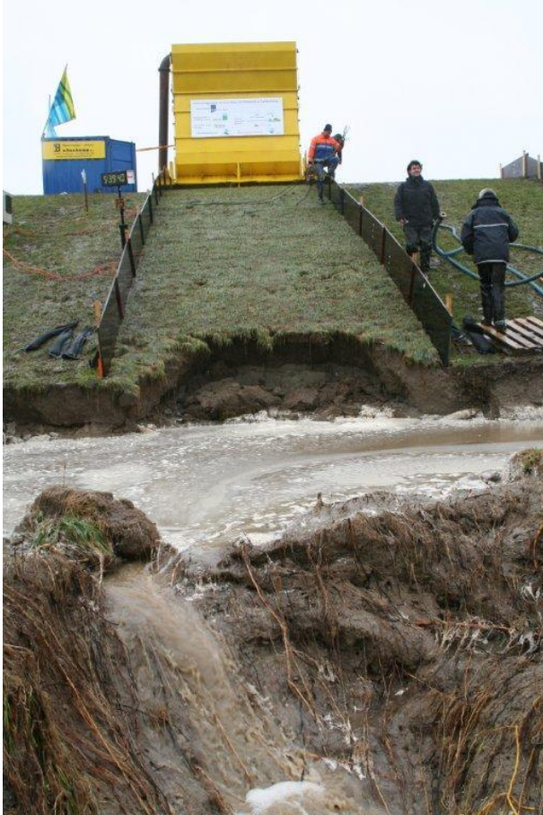
Foto B22. Kattendijke. Sectie 1. Aan het einde van de proef. Geen schade aan het talud, bezwijken van teen met onderhoudsweg, leidende tot headcut erosie op het talud.
