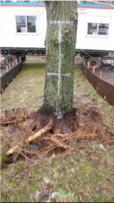
Figuur 8.1 Schade als gevolg van stroomconcentratie en turbulentie na grote overslagdebieten (Golfoverslagproeven Vechtdijk, 5½ uur 50 l/s per m)
