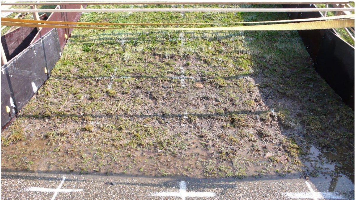
Figuur B103. Tholen, sectie A, oploop buitentalud. Na Ru 2% op bermniveau.
