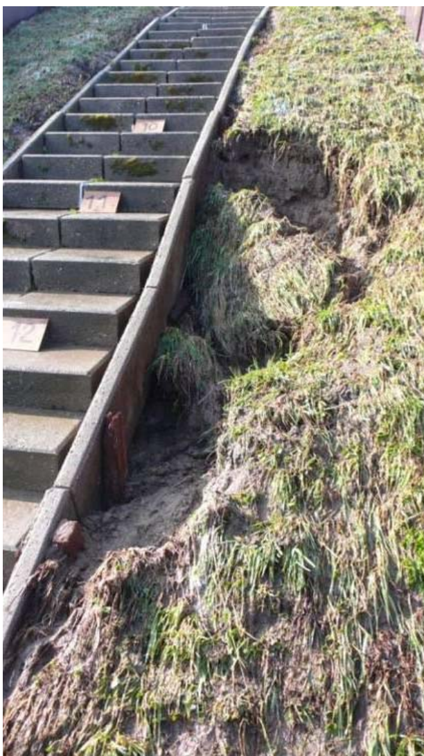
Figuur 8.3 Schade als gevolg van stroomconcentratie in combinatie met verminderde sterkte door onder andere het gebruik van onkruidwerend middel langs de trap (Golfoverslagproef op dijk bij Poortvliet, Tholen, na 2 uur 5 l/s per m)
