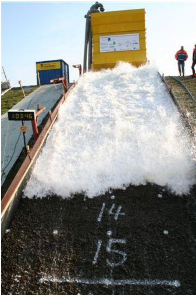
Foto B25. Kattendijke. Elastocoast. Proef met 125 l/s per m. Identiek aan open asfaltbeton.
