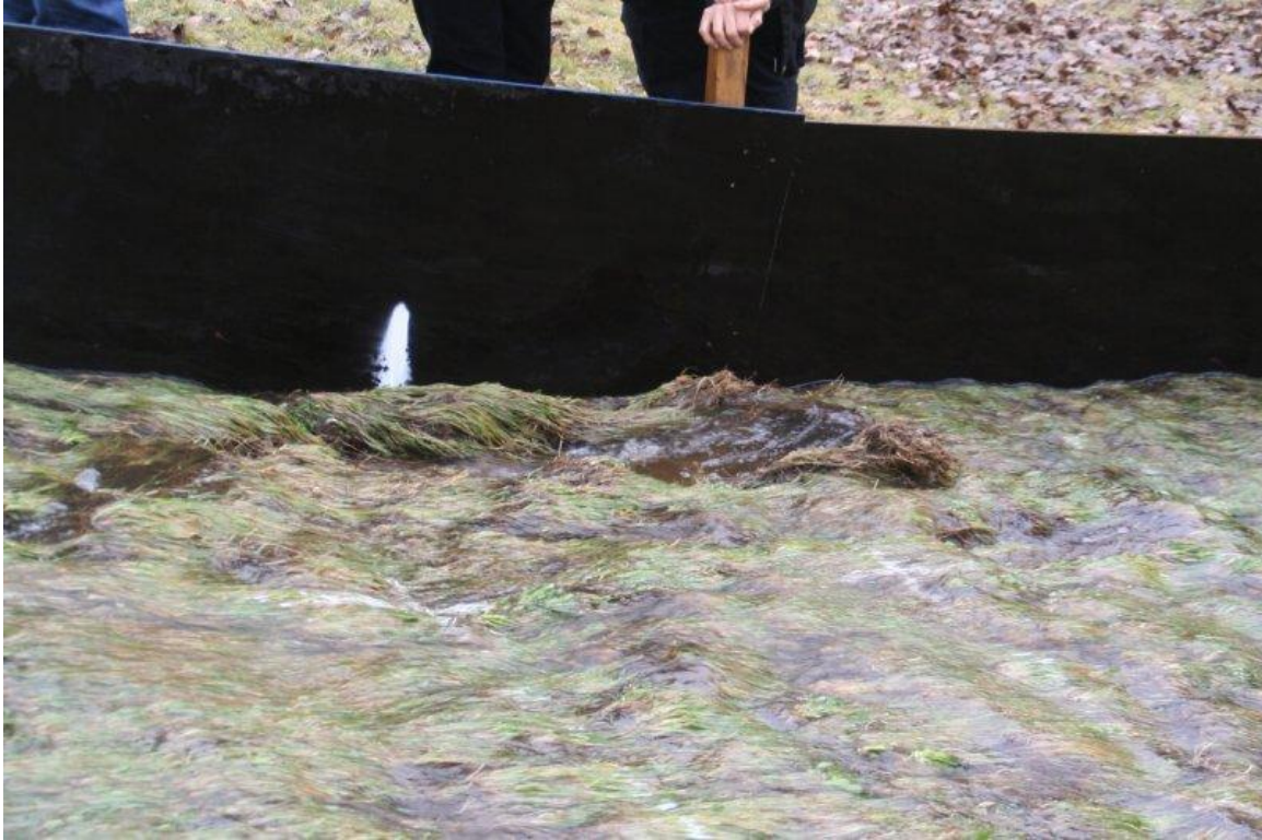
Foto B56. Vechtdijk. Rivierregime, proef 4; Eerste schade
