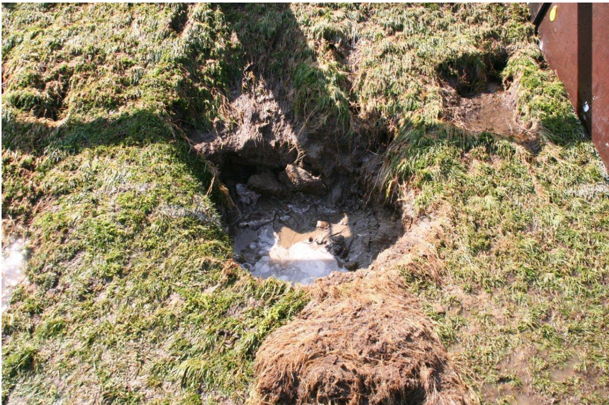
Figuur B101. Tholen, sectie 4, binnentalud. Bezweken teen.
