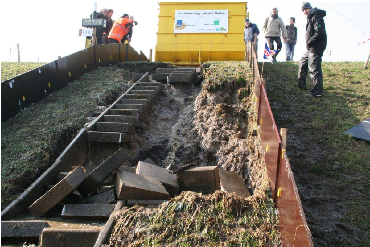
Figuur B84. Tholen. Sectie 2, trap. Volledig bezwaken trap en talud.
