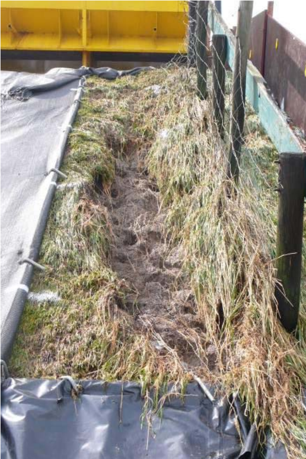
Figuur 8.4 Sponsachtige ophoging langs hekwerk (Golfoverslagproef op dijk bij Poortvliet Tholen)
