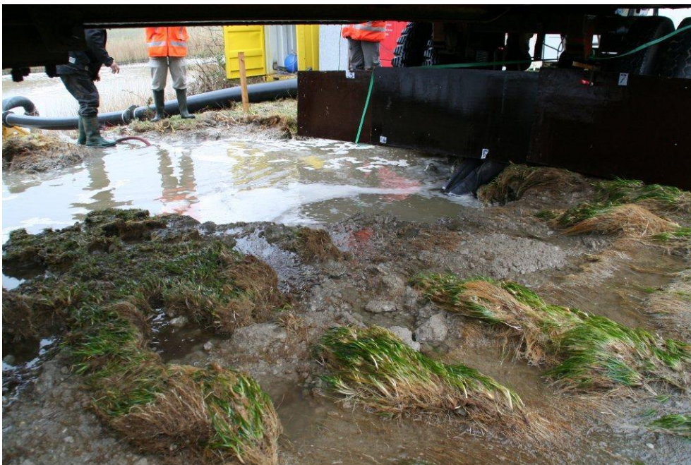
Foto B21. Kattendijke. Sectie 1. Schade aan teen voordat meetwagen moest worden verplaatst.
