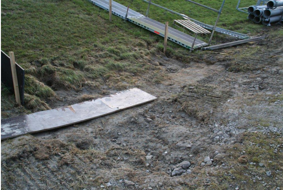
Foto B24. Kattendijke. Sectie 2. Benedentalud met teen, na de proef. De onderhoudsweg was afgedekt en kon niet worden beschadigd.
