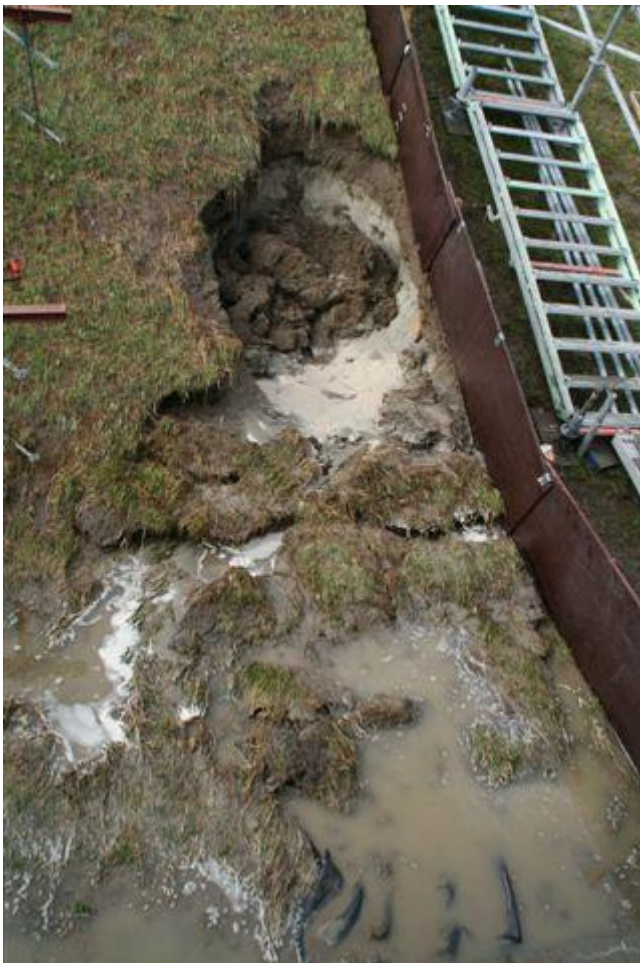
Foto B19. St Philipsland. Talud bezweken en ook de reeds afgedekte teen.
