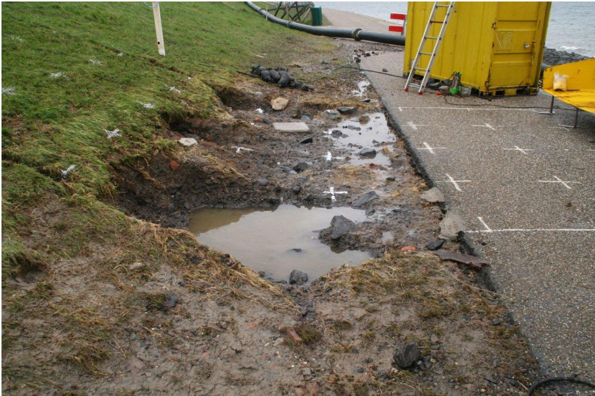
Figuur B107. Tholen, sectie A, oploop buitentalud. Einde proef, na Ru_{2\%} op 2,4 m boven bermniveau.
