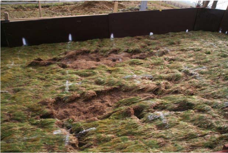
Figuur 2.4 Golfoverslagproef Vechtdijk. Afstropen van gras van een zanddijk, waarna nog een sterke doorwortelde en gecementeerde (zie paragraaf 3.3.1) toplaag overbleef
