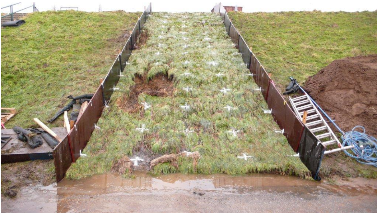
Figuur B77. Tielrode, België. Sectie 4. Bezweken talud.
