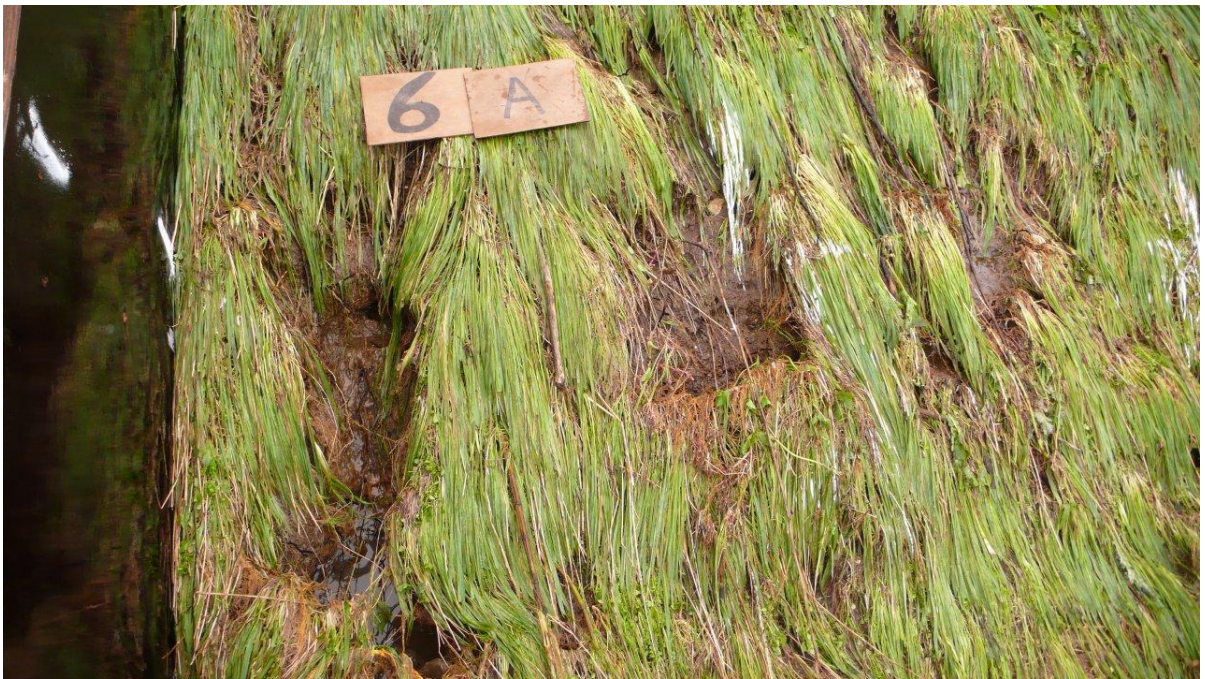
Figuur B73. Tielrode, België. Sectie 2. Meerdere plekken schade.
