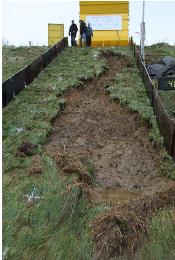
Figuur B71. Tielrode, België. Sectie 1. Bezweken talud.
