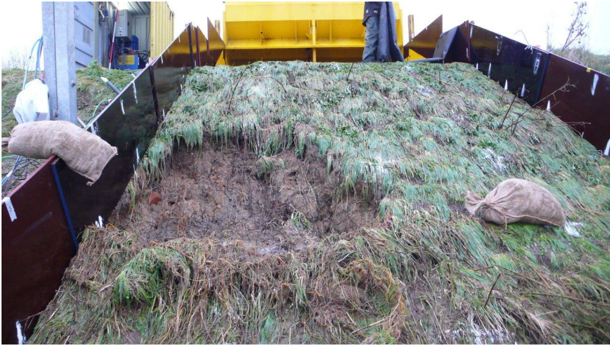
Figuur B74. Tielrode, België. Sectie 2. Bezweken talud.
