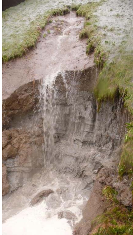
Figuur 5.7 Afbrokkelen van de bovenrand van een grasbekleding bij een zanddijk met een 0,6 m dikke kleilaag (Waddenzeedijk Friesland bij de Boonweg)
