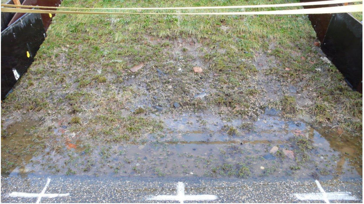
Figuur B104. Tholen, sectie A, oploop buitentalud. Na Ru_{2\%} op 0,8 m boven bermniveau.
