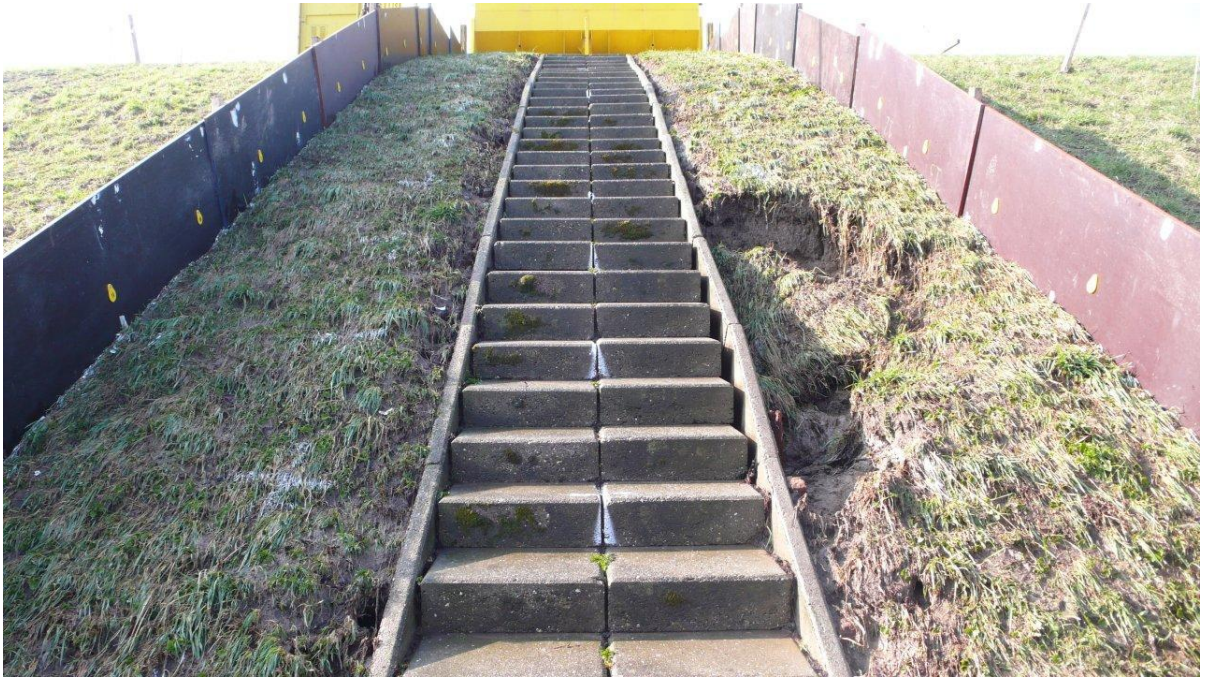
Figuur B82. Tholen. Sectie 2, trap. Bezweken talud.
