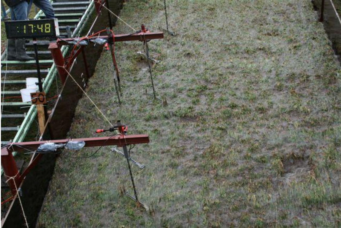
Foto B18. St Philipsland. Begin van schade aan het talud (twee plekken)
