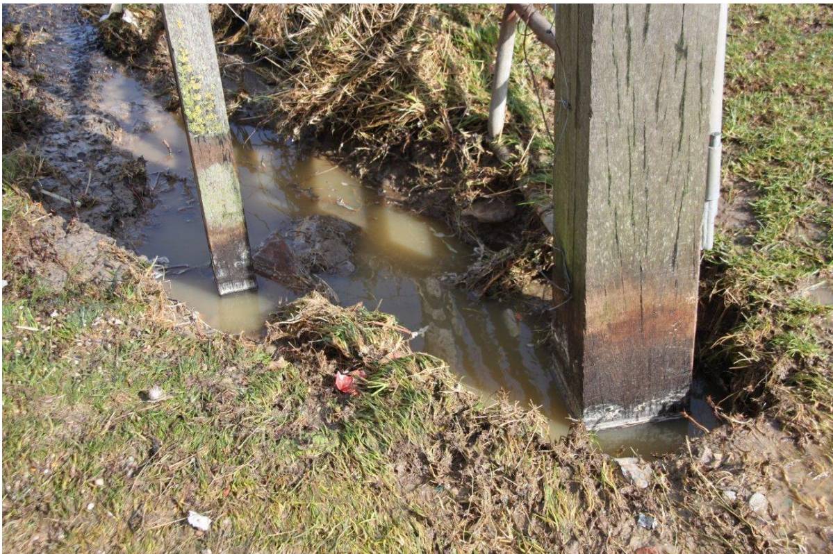
Figuur B93. Tholen. Sectie 3, afrastering. Begin erosie rondom paal 0,2x0,2 m.
