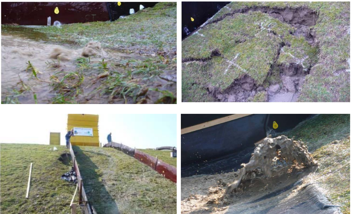
Figuur 3.6 Ongewenste combinatie van een slechte grasmat, een dunne kleilaag en graverij waardoor ondermijning van de kleibekleding optreedt (Zeedijk nabij Poortvloet Tholen).
