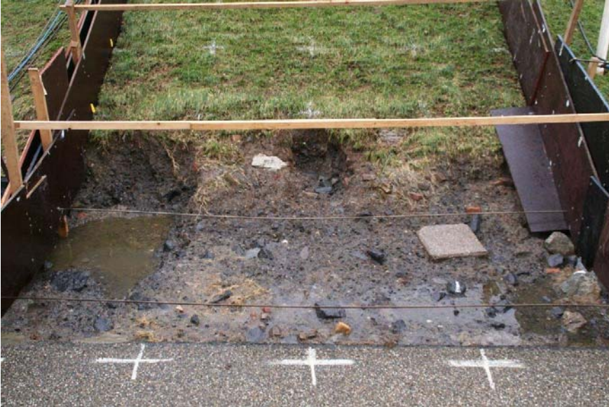
Figuur 5.9 Schade bij de overgang van buitenberm naar bovenbeloop van het buitentalud door golfploep.
