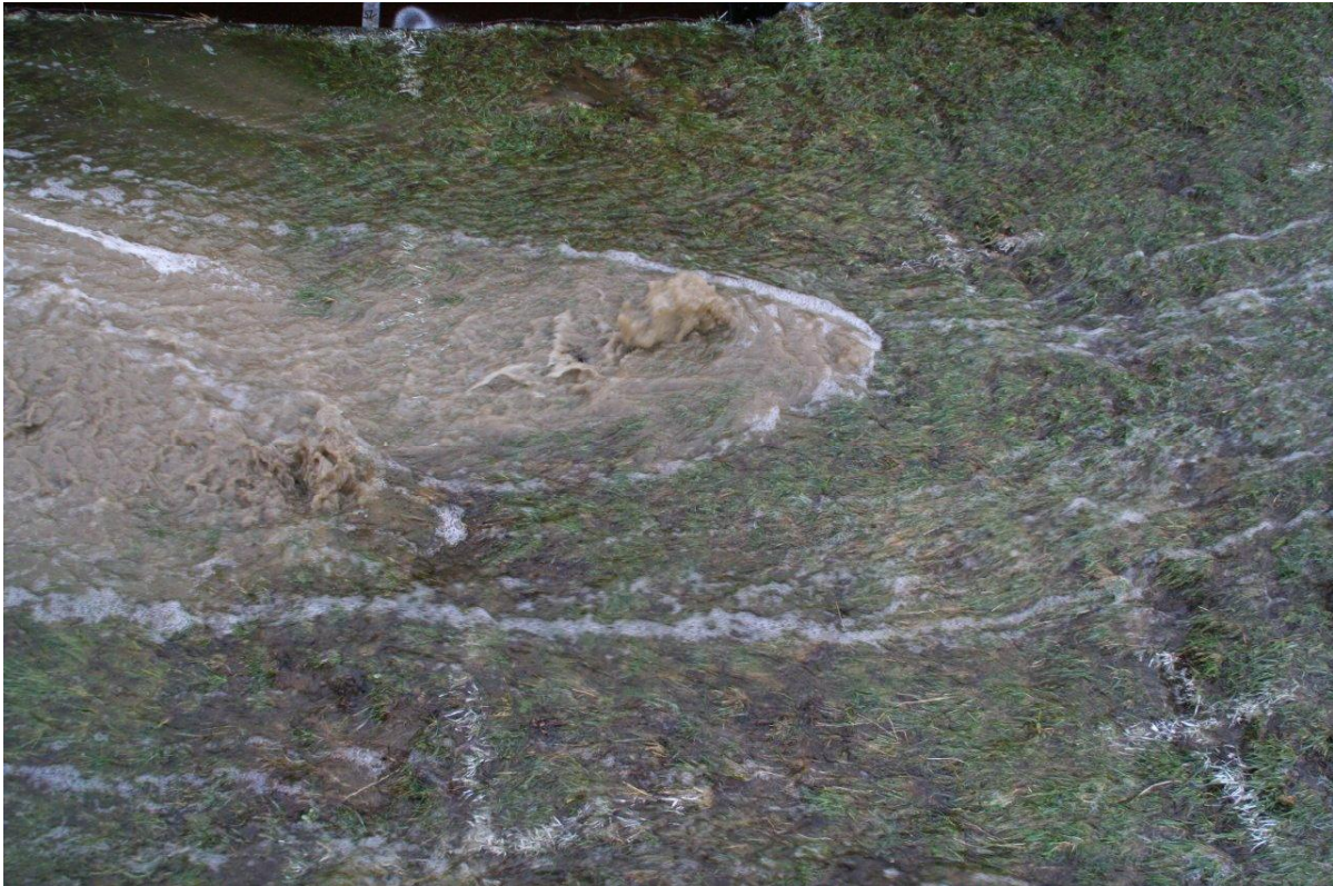
Figuur B89. Tholen. Sectie 3, afrastering. Zandmeevoerende wellen.
