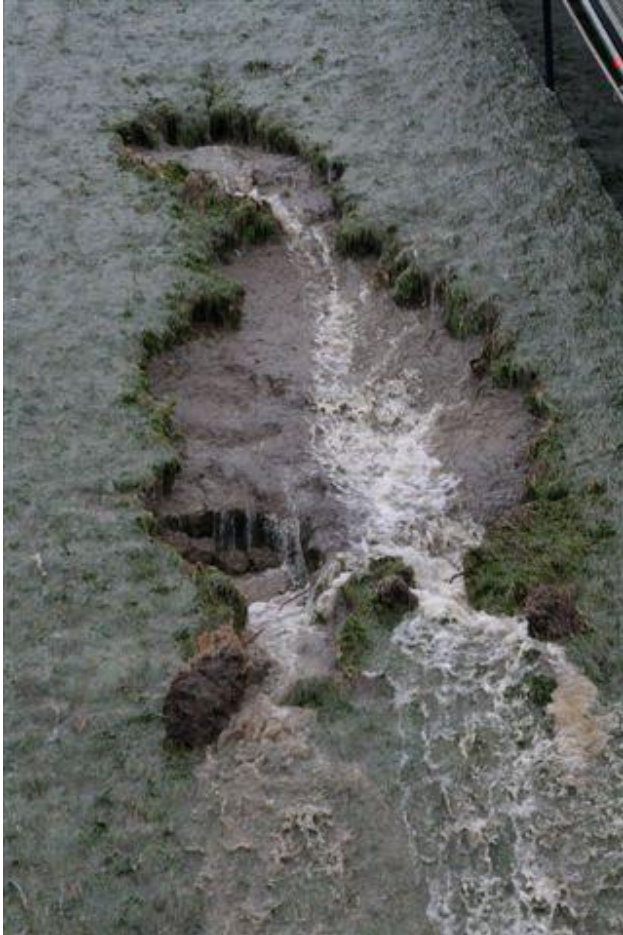
Foto B16. Boonweg, Friesland; sectie 4. Ontwikkeling head cut erosie.
