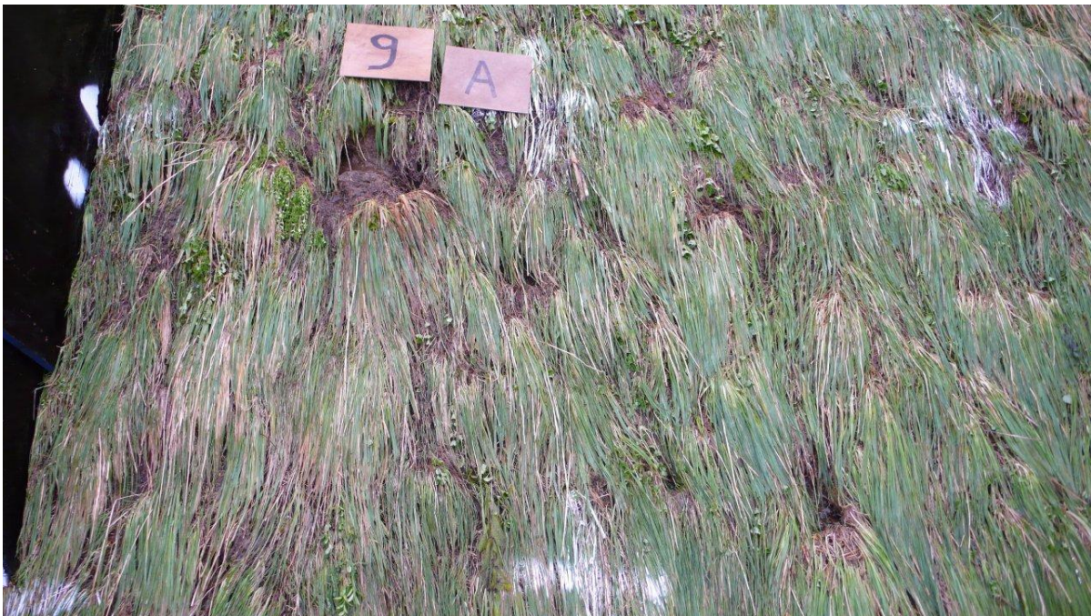
Figuur B75. Tielrode, België. Sectie 4. Begin schade.
