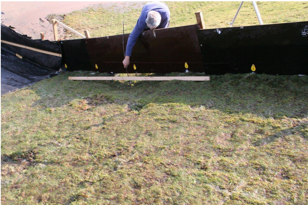
Figuur B97. Tholen, sectie 4, binnentalud. Verzakking talud.
