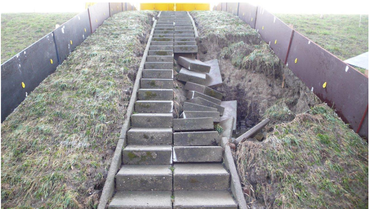
Figuur B83. Tholen. Sectie 2, trap. Bezweken trap.
