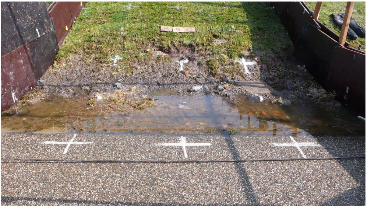
Figuur B105. Tholen, sectie A, oploop buitentalud. Na Ru_{2\%} op 1,6 m boven bermniveau.
