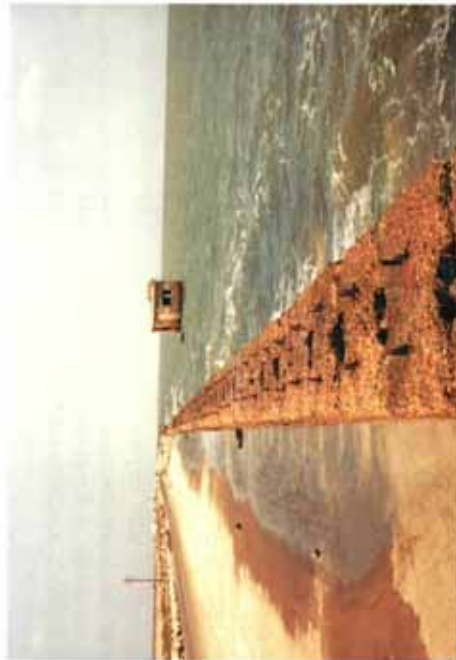
Fig. 4.51 Strandmuur zonder droog strand.
