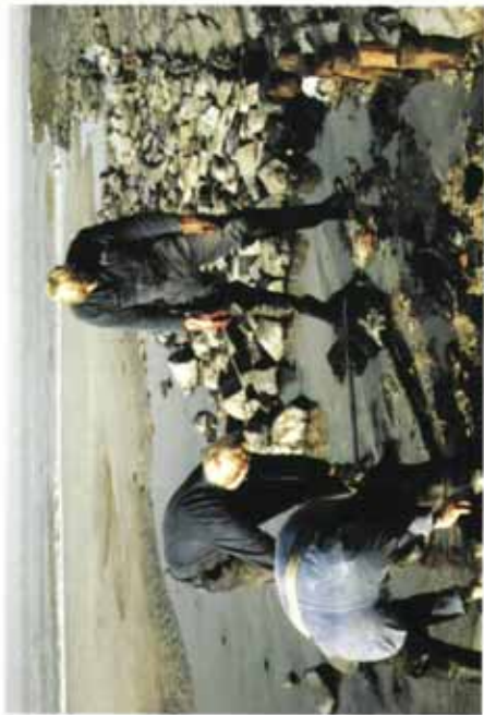
Fig. 7.13 Onderhoud van een strandhoofd; bezetten van een steenzetting na schade door stranding van een schip.
