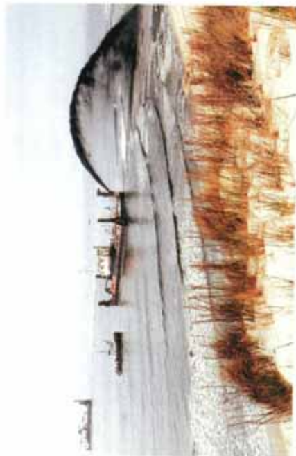
Fig. 4.24 Uitvoering van een voorover- en strandsuppletie
