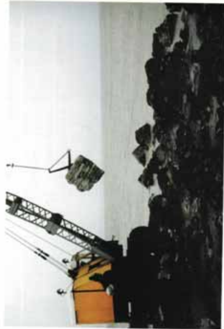
Fig. 4.45 Onderhoud van strandhoofden met zwaar matmateriaal.
