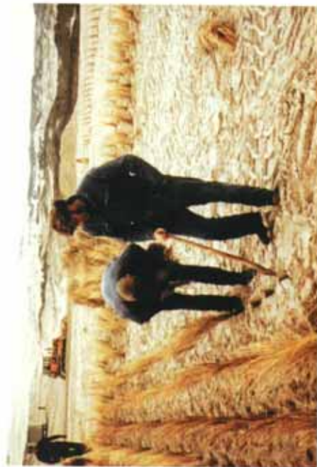
Fig. 7.11 Aanbrengen van helm om het gesuppleerde zand vast te leggen
