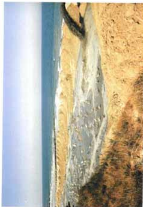
Fig. 4.17 Uitvoering van een strandsuppletie.
