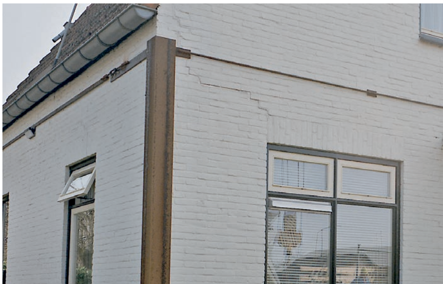
Figuur 2.8 Schade aan een gebouw door zettingen tijdens de uitvoering
