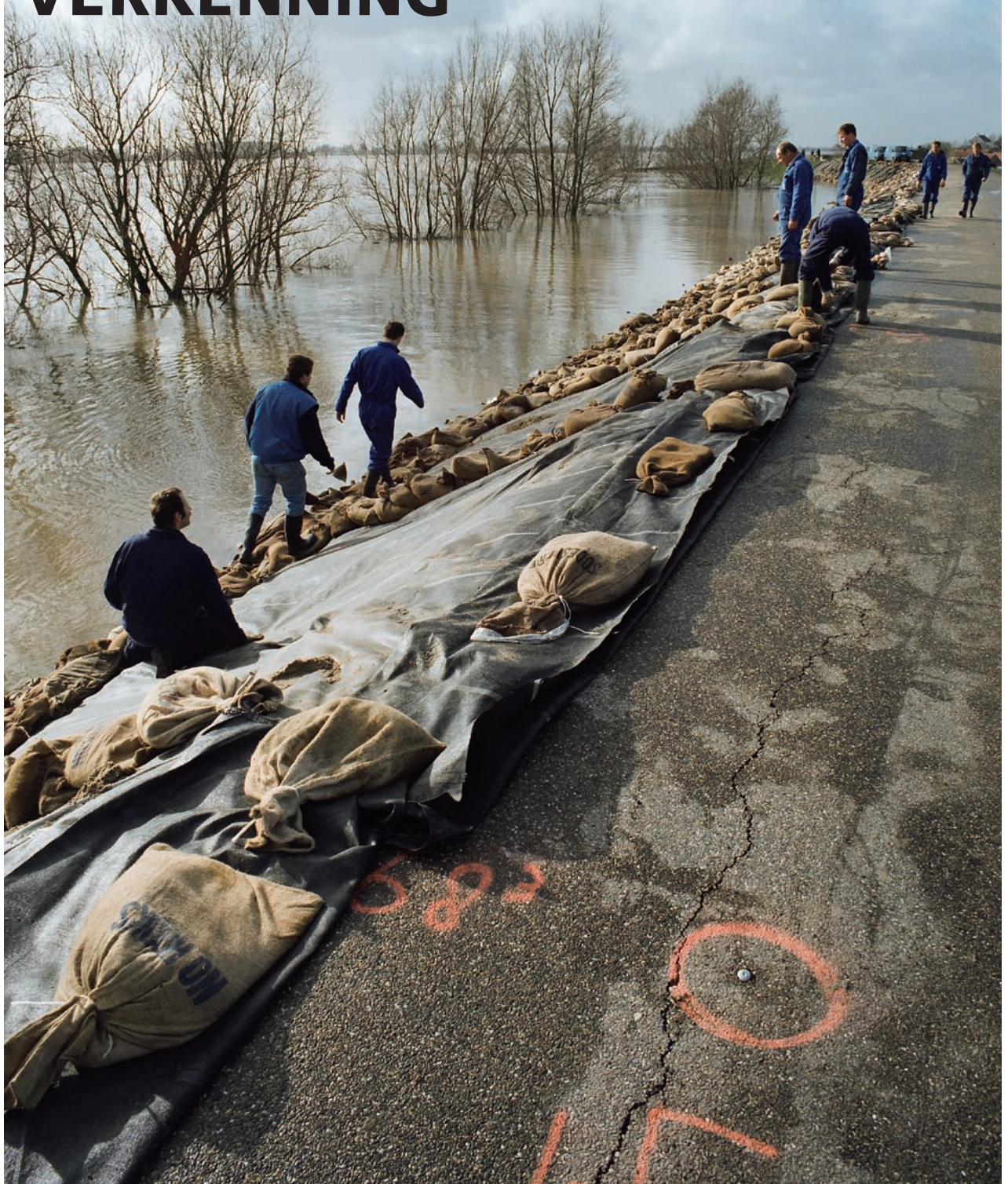
Noodreparaties van de dijk bij Ochten tijdens extreem hoogwater op de Waal
