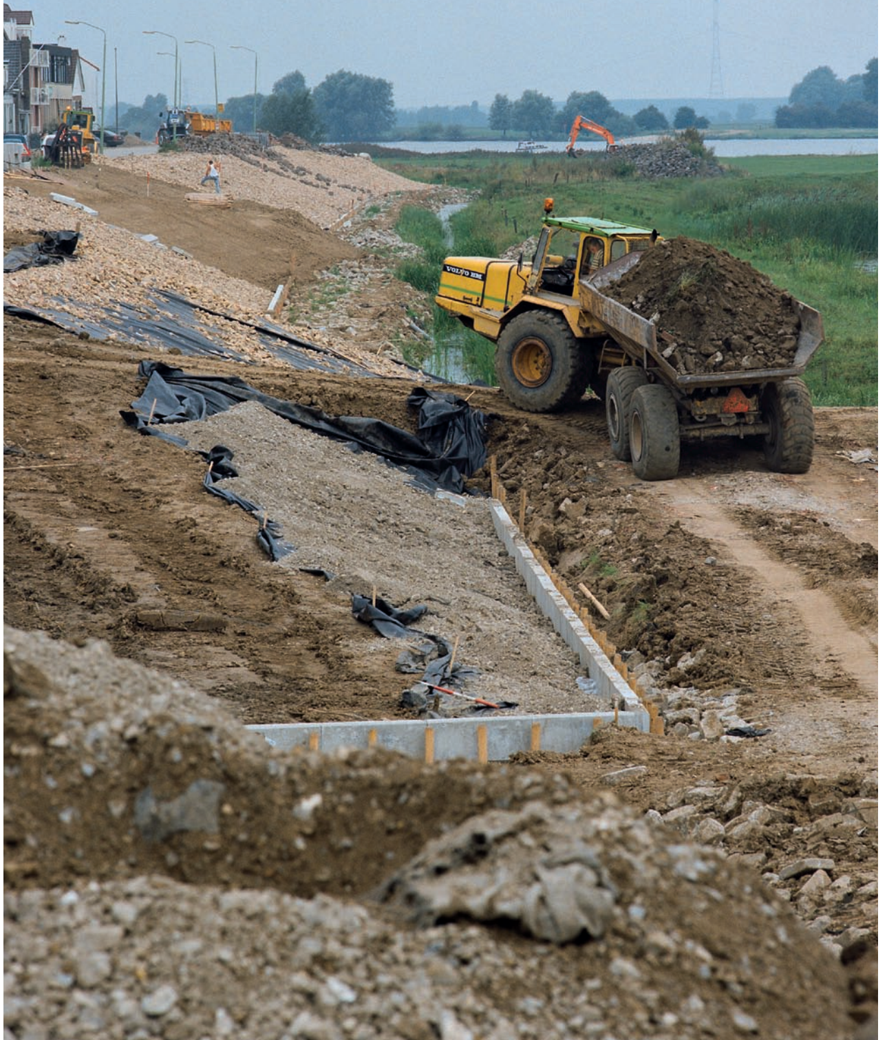
Verbetering van de Sasdijk bij Werkendam
