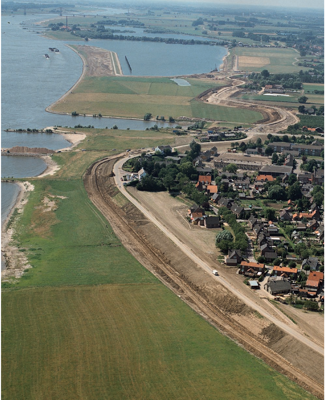
Luchtfoto Ochten: werken aan dijkversterking langs de Waal
