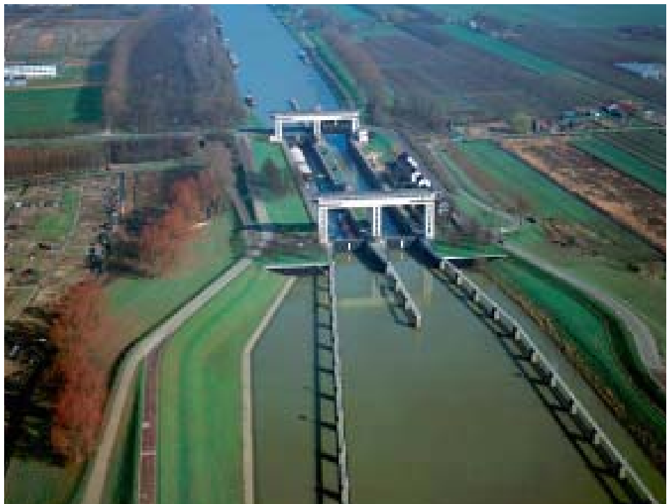
Foto 2.1 Waterkerend kunstwerk: Prinses Beatrixsluizen (Lekkanaal) (foto MD)
