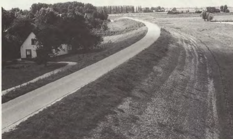
Dijkbekleding heeft grote invloed op de verschijningsvorm van de dijk
