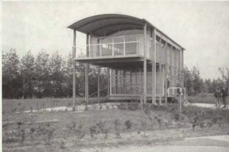
De nieuwe dijkwoning
