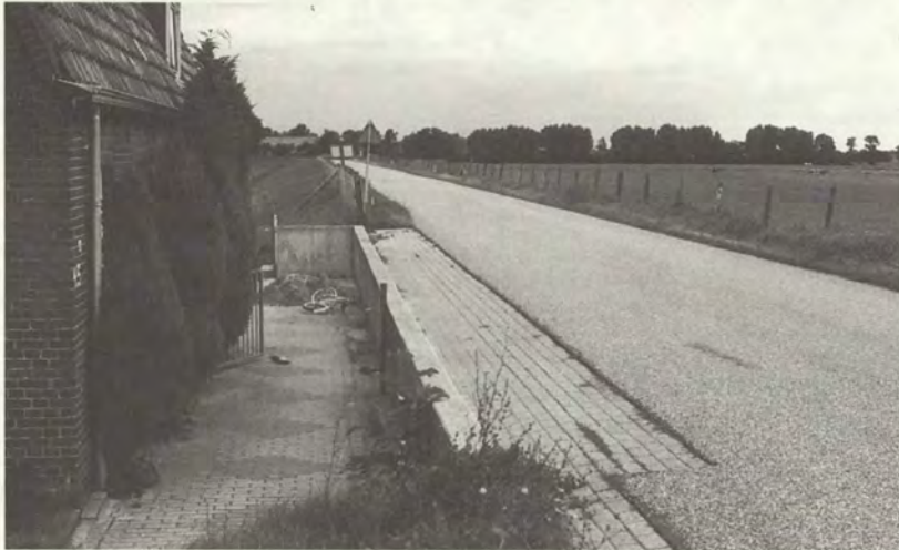
In dit geval is de dijk niet naar buiten gelegd. Met een kleine keermuur is het knelpunt opgelost.
