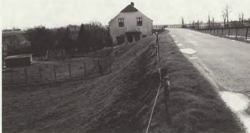
Erosie van het binnentalud door veepadjes
