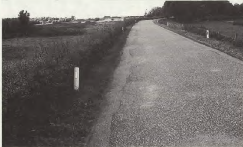
Karakteristieke IJsseldijk met smalle bermen en een smal profiel
