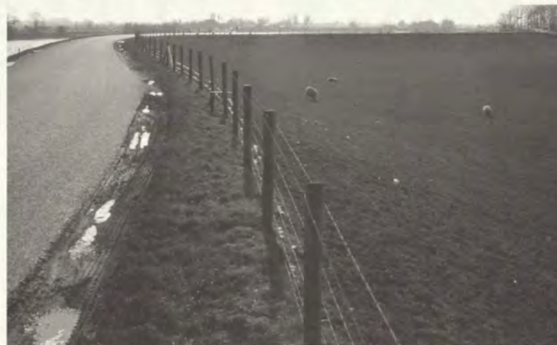
Vloeiend talud in nieuwe Lekdijk
