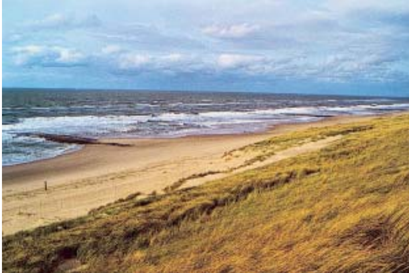
Figuur 5.7: Onderhoud zandige waterkering en harde objecten: helm, afrastering en strandhoofden.
