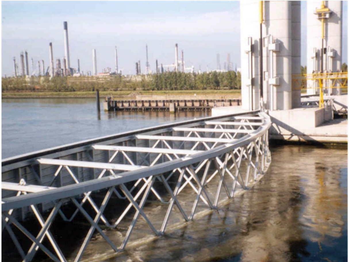
Figuur 1 De Hartelkering in het Hartelkanaal in gesloten stand bij een test tijdens de testfase. (Bron: https://beeldbank.rws.nl , Rijkswaterstaat)
