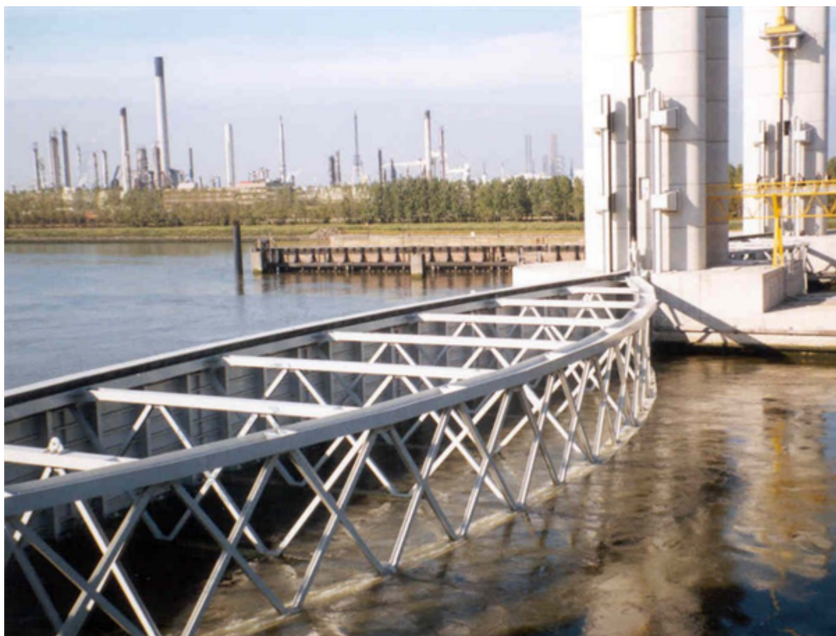
Figuur 1 De Hartelkering in het Hartelkanaal in gesloten stand bij een test tijdens de testfase. (Bron: https://beeldbank.rws.nl , Rijkswaterstaat)
