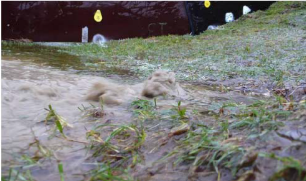
Figuur 5 Uitspoelen van zand door een mollengang onderaan het talud, Golfoverslagproef Tholen.
