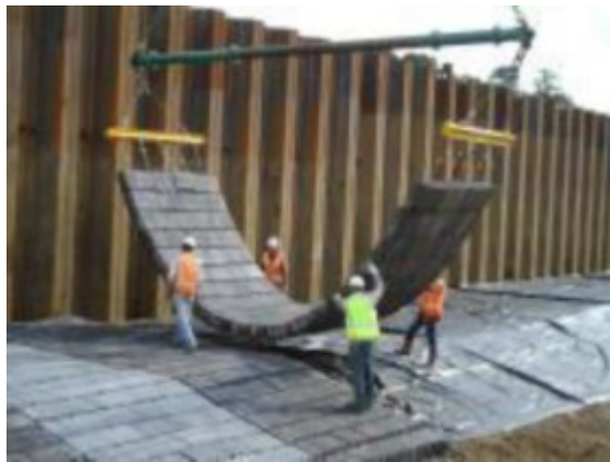
Figuur 3: Plaatsing blokken met kabels
