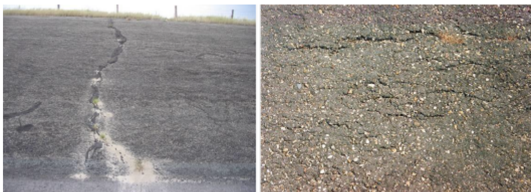
Figuur 1 Links: temperatuurscheuren waarbij zand van onder de bekleding is gekomen als gevolg van activiteit van mieren. Rechts: walscheuren.
