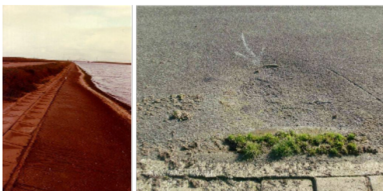
Figuur 11 Links: zakking als gevolg van zettingen van de ondergrond. Rechts: zakking als gevolg van uitspoeling, in dit geval via de onderste overgangsconstructie. Let ook op de verzakte blokken onder
