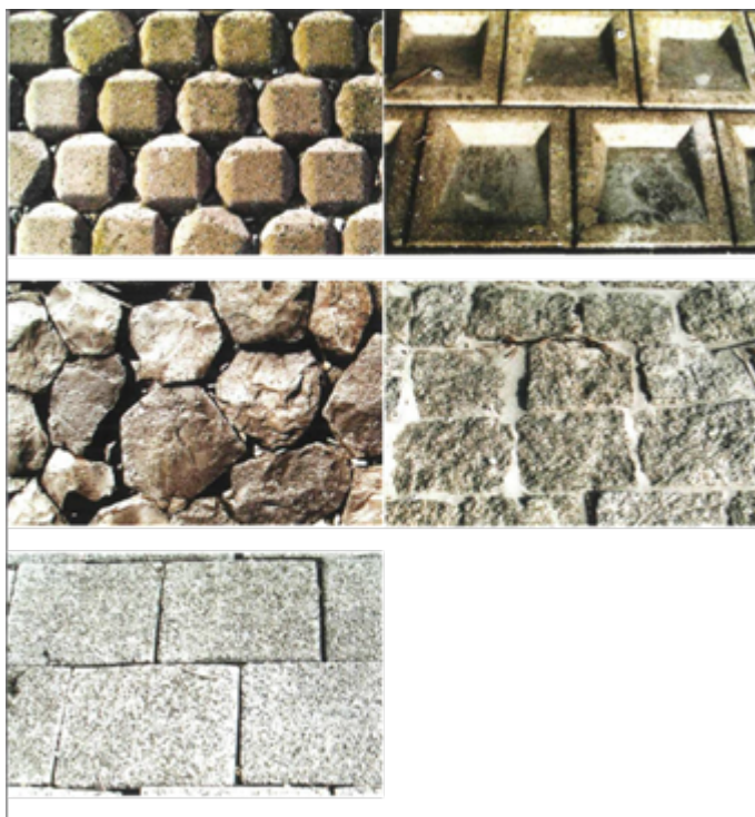
Figuur 1 Typen toplagen met standaardelementen.
