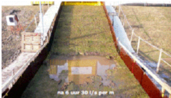
Figuur 3 Jet-erosie bij de overgang van een talud naar horizontaal.
