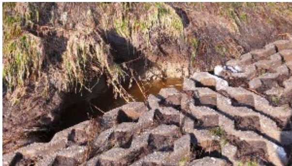
Figuur 3 Overgang van talud naar wegovergang met doorgroeistenen. Golfverslagproeven Vechtdijk.
