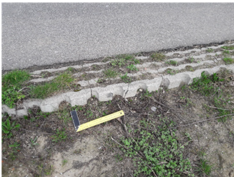
Figuur 8 Voorbeeld van een niet-nette overgang, aansluiting tussen blokken en grasbekleding bevat grote gaten.
