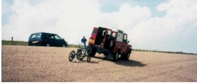
Figuur 1 Nucleaire dichtheidsmeter in bedrijf op een talud met asfaltverharding.
