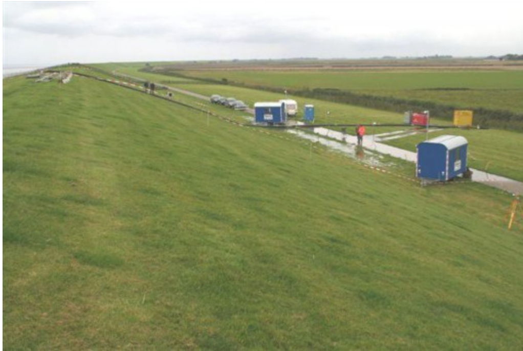
Figuur 2 Opstelling afschuifproef met een 30 m lange buis op de kruin van de dijk. Friese Waddenzeedijk nabij de Boonweg.
