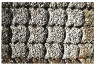
Figuur 3 Betonzuilen met ecotop.
