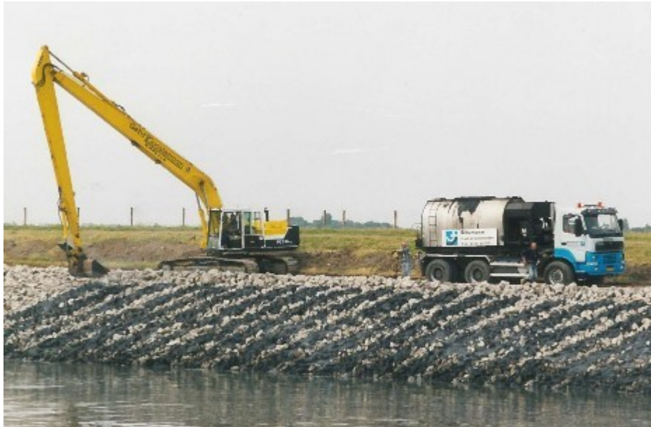
Figuur 5 Strokenpenetratie in uitvoering. (Foto Hydraphalt).
