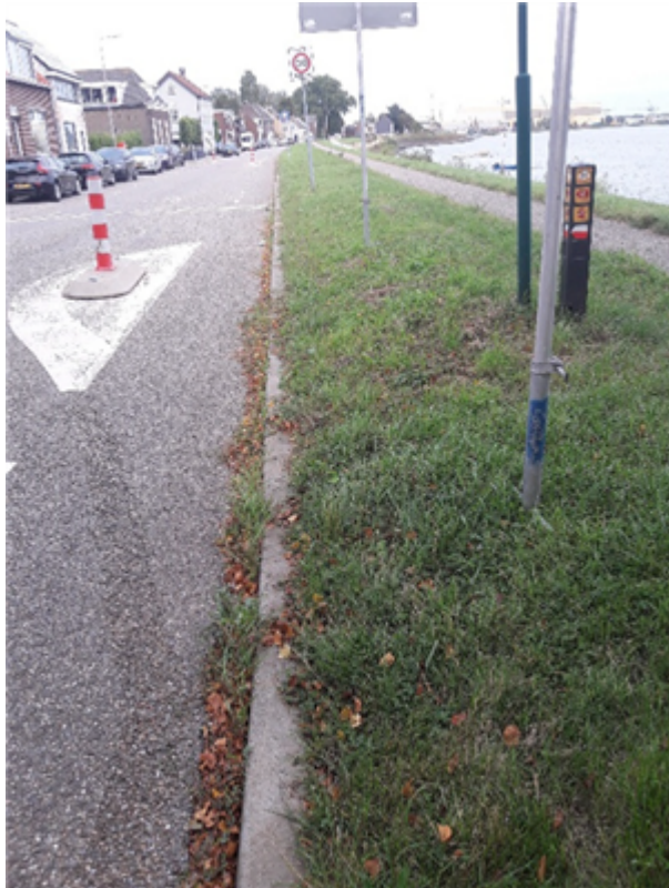
Figuur 2 Voorbeeld van een 'nette overgang'. Rechts op de kruin bevindt zich een vlakke aansluiting tussen de grasbekleding en het asfalt voetpad. Links daarvan bevinden zich enkele niet waterkerende objecten van klein formaat (kleiner dan 15 \times 15 \text{ cm}^2 ). Weer links daarvan bevindt zich een aansluiting van een grasbekleding op een opsluitband van een rijweg.
