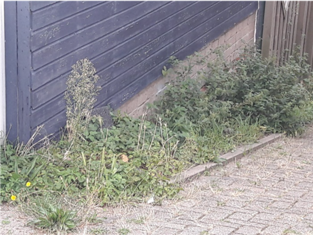
Figuur 9 Voorbeeld van een pand in de bekleding.
