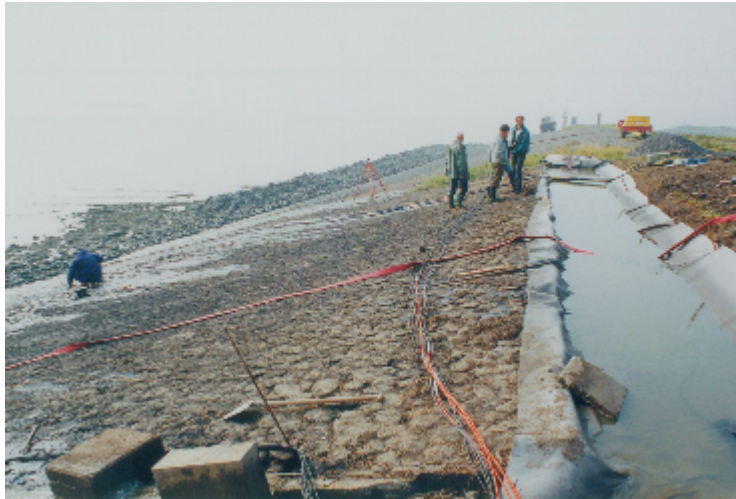
Figuur 5 Infiltratiemeting in Kruiningen.
