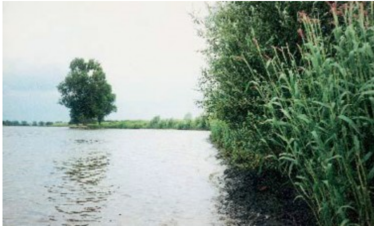
Figuur 2 Begroeide oever met open steenasfalt langs de Maas bij Bokhoven, 1995. (Foto Oranjewoud).
