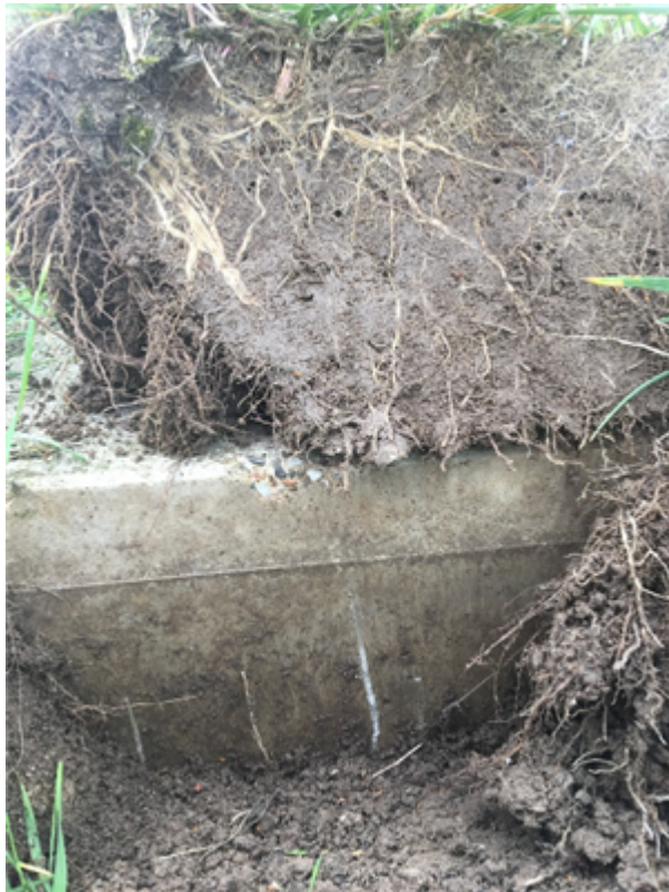
Figuur 1 Nette aansluiting wortelnet van de grasbekleding op de overgang, aangetoond door het steken van een plag.
