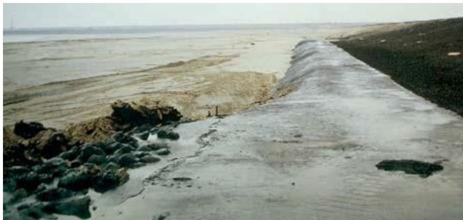
Figuur 1 Asfaltmastielslab als bescherming van de teen van de dijk tegen ontgroning op de Veersedam.
