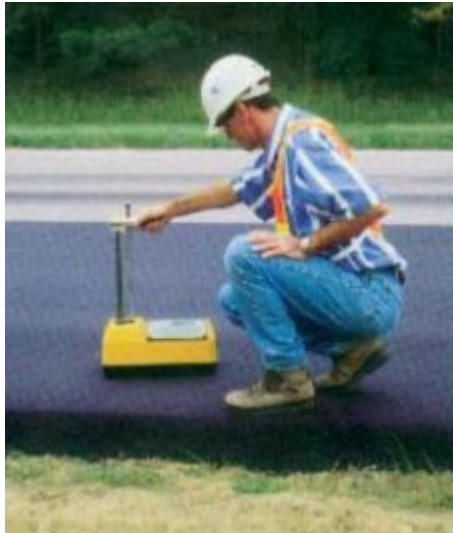
Figuur 1 Nucleaire dichtheidsmeter op een asfaltverharding. (Foto NPC).
