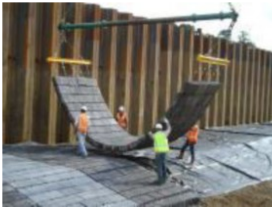
Figuur 3: Plaatsing blokken met kabels
