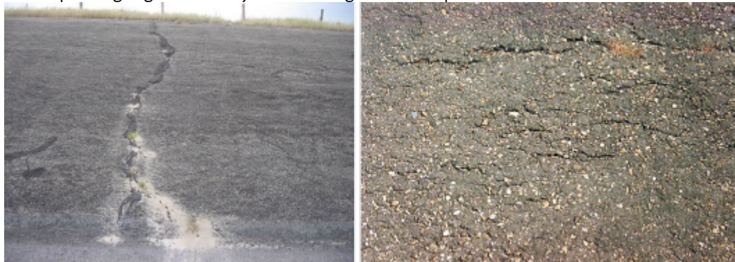
Figuur 1 Links: temperatuurscheuren waarbij zand van onder de bekleding is gekomen als gevolg van activiteit van mieren. Rechts: walscheuren.
