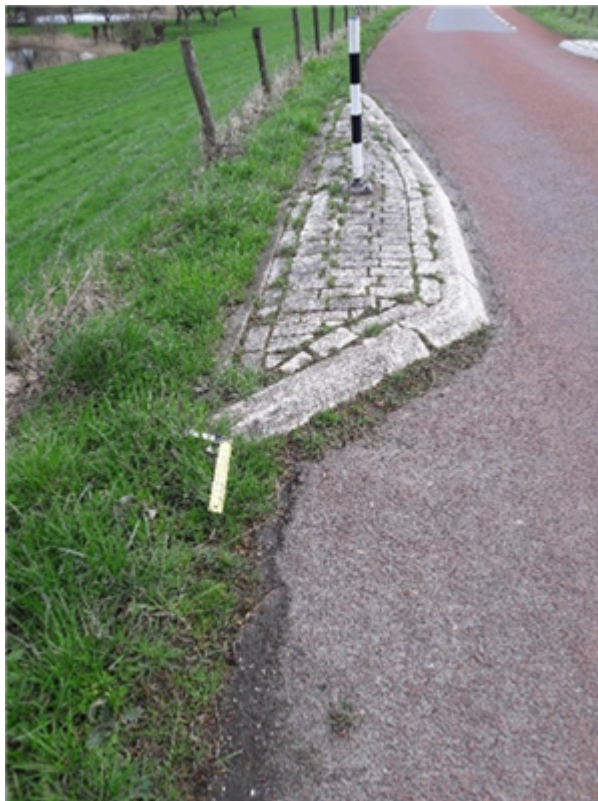
Figuur 5 Voorbeeld van een 'nette overgang'. Nette aansluiting van de grasbekleding op een asfaltweg en een klinkerbestrating. Daarnaast de aansluiting op een raster.
