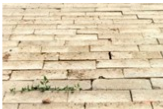
Figuur 4 Gekantelde betonblokken.
