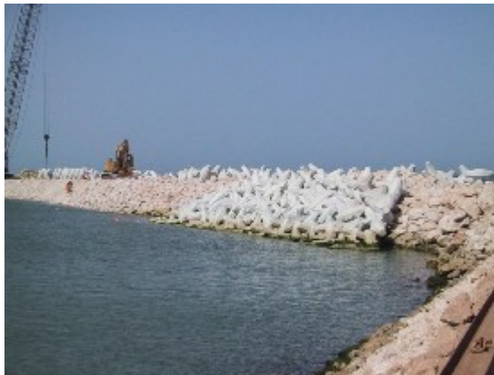
Figuur 1: Losgestorte materialen als oeverbekleding (links), interlock elementen (rechts)
