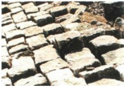
Figuur 7 Onregelmatige granietblokken op een gelijkmatige granulaire laag.
