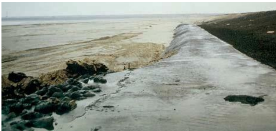
Figuur 1 Asfaltmastiekslab als bescherming van de teen van de dijk tegen ontgronding op de Veersedam.
