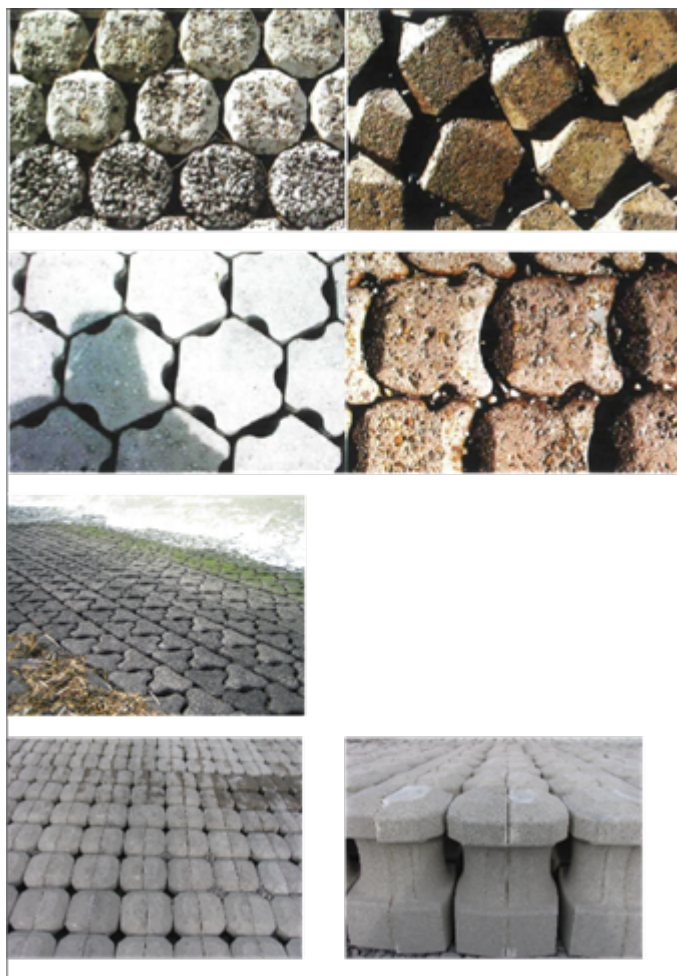
Figuur 2 Zes typen zuilenzetting.
