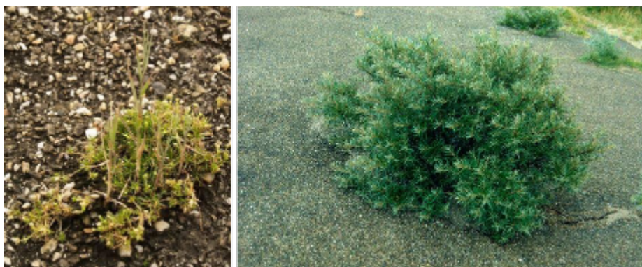
Figuur 13 Links: begroeiing in de bekleding (riet en spurrie). Rechts: begroeiing (duindoorn, struik) door de bekleding.
