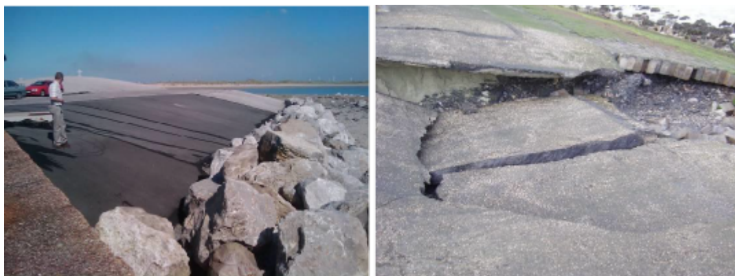
Figuur 4: Links: lokaal vervangen bekleding na schade door uitspoelen van zand bij een slecht uitgevoerde aansluiting op de betonnen constructie links. Rechts: gat na het instorten van de toplaag na ondermijning als gevolg van het bezwijken van de aangrenzende steenzetting.
