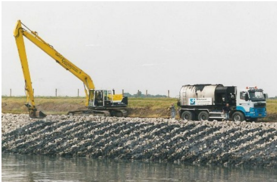
Figuur 5 Strokenpenetratie in uitvoering. (Foto Hydraphalt).
