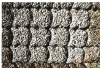
Figuur 3 Betonzuilen met ecotop.
