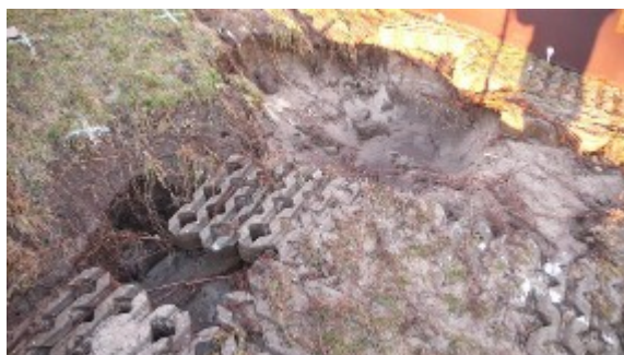
Figuur 4 Jet-erosie bij de overgang van een talud naar horizontaal.
