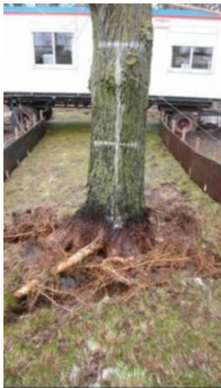
Figuur 1 Schade als gevolg van stroomconcentratie en turbulentie na grote overslagdebieten.
