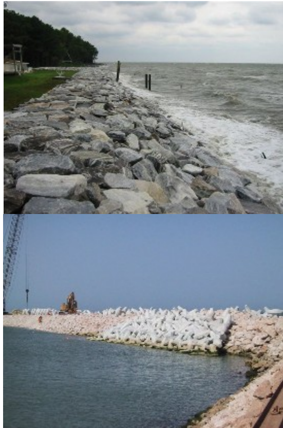
Figuur 1: Losgestorte materialen als oeverbekleding (links), interlock elementen (rechts)
