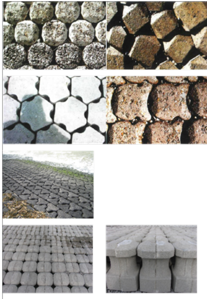
Figuur 2 Zes typen zuilenzetting.
