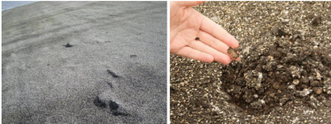
Figuur 8 Links: enkele zeer prominente opbollingen; rechts: open gebroken opbolling toont lokaal volledig uiteengevallen grindasfalt.
