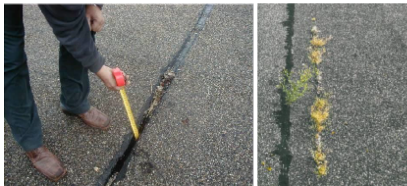
Figuur 2 Links: openstaande naad die al eerder was gevuld. Rechts: liplas met links in beeld een gevulde naad met een enkele plant en even rechts daarvan een strook vergeelde begroeiing in de scheur van de afgebroken lip (= situatie van Figuur 3 rechtsonder).
