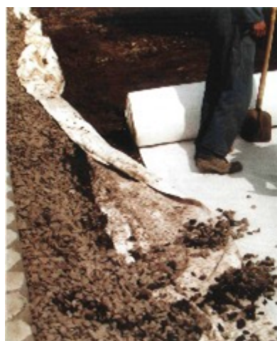
Figuur 2 Geokunststof op de rol tijdens aanbrengen.
