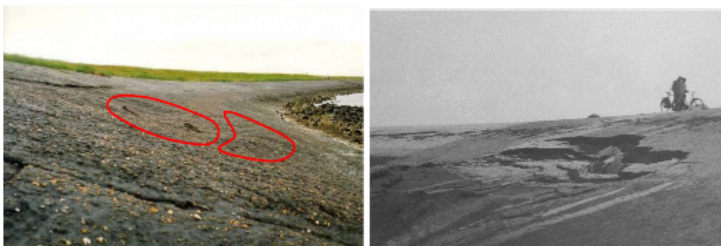
Figuur 10 Voorbeelden van instabiliteit van ondergrond.
