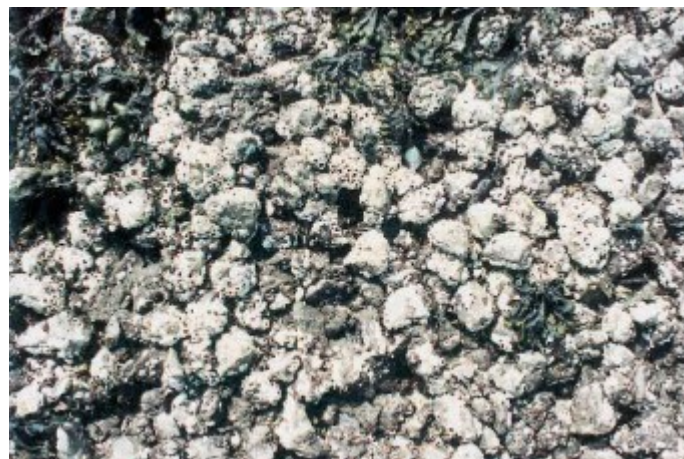
Figuur 2 Biologische aantasting van open steenasfalt door zeepokken op Neeltje Jans, 1989. (Foto: Oranjewoud).
