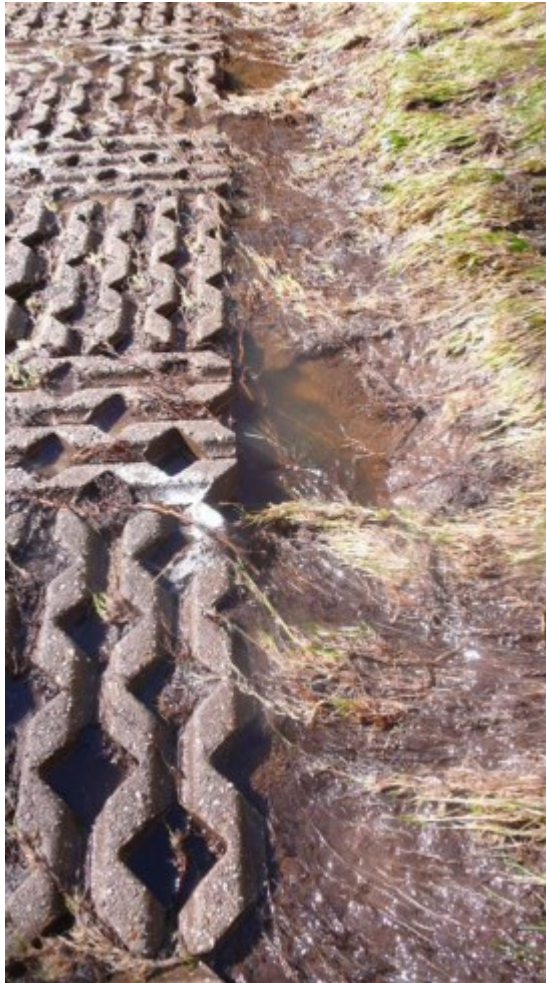
Figuur 2 Overgang van talud naar wegovertgang met doorgroeistenen. Golfoverslagproeven Vechtdijk.
