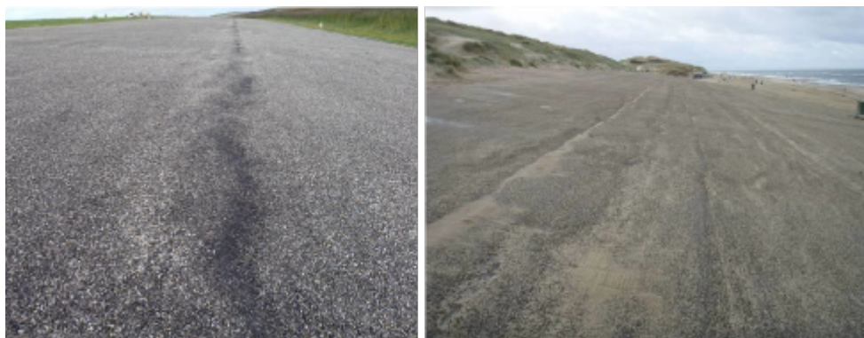
Figuur 9 Enkele strookvormige opbollingen.
