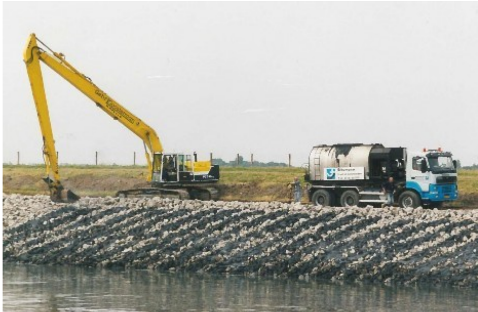
Figuur 5 Strokenpenetratie in uitvoering. (Foto Hydraphalt).
