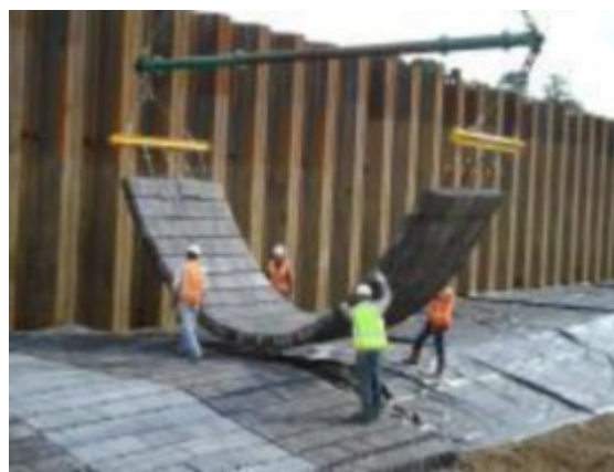
Figuur 3: Plaatsing blokken met kabels
