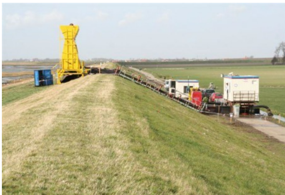
Figuur 1 Meetopstelling van de golfoverslagsimulator op een dijk.
