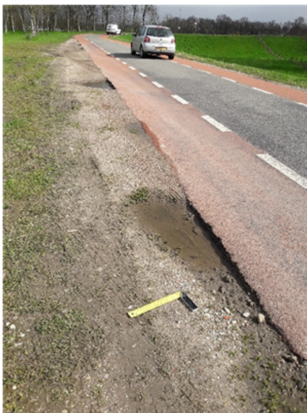
Figuur 7 Voorbeeld van een niet-nette overgang, aansluiting tussen asfalt en grasbekleding bevat grote gaten.
