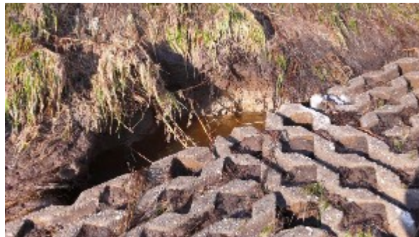
Figuur 3 Overgang van talud naar wegovertgang met doorgroeistenen. Golfoverslagproeven Vechtdijk.
