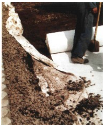
Figuur 2 Geokunststof op de rol tijdens aanbrengen.
