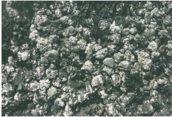
Figuur 16 Aantasting door zeepokken.
