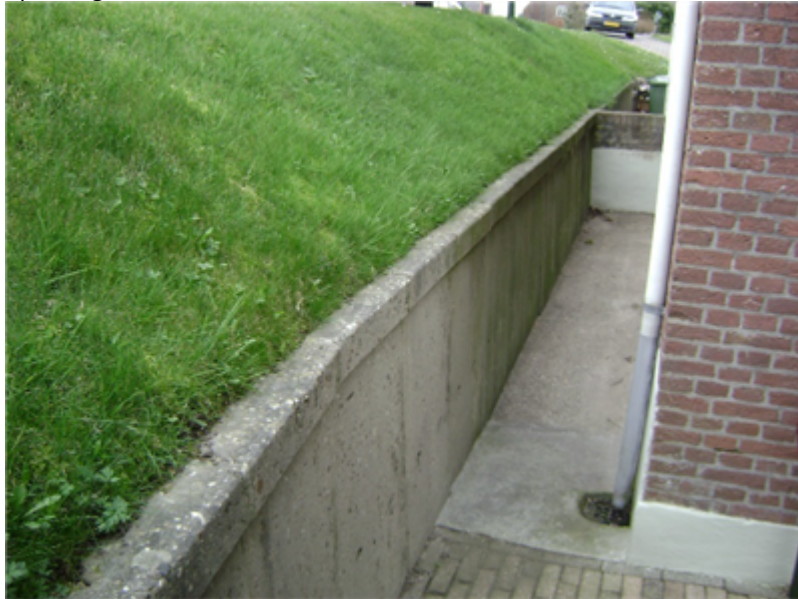
Figuur 4 Voorbeeld van een 'nette' overgang. Nette aansluiting van de grasbekleding op een keermuur.
