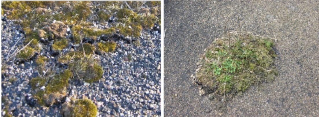
Figuur 12 Begroeiing op asfalt. Links: overgroeiing met mos. Rechts: kluit met begroeiing die los op bekleding ligt.
