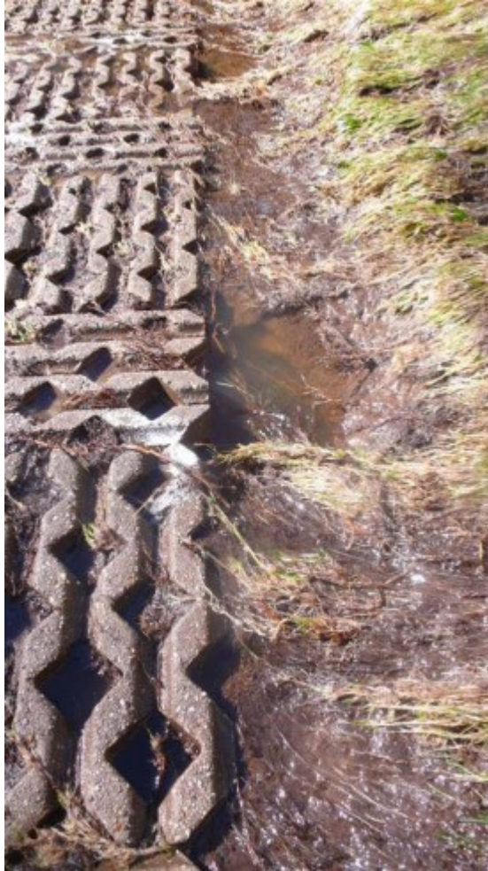
Figuur 2 Overgang van talud naar wegovergang met doorgroeistenen. Golfverslagproeven Vechtdijk.
