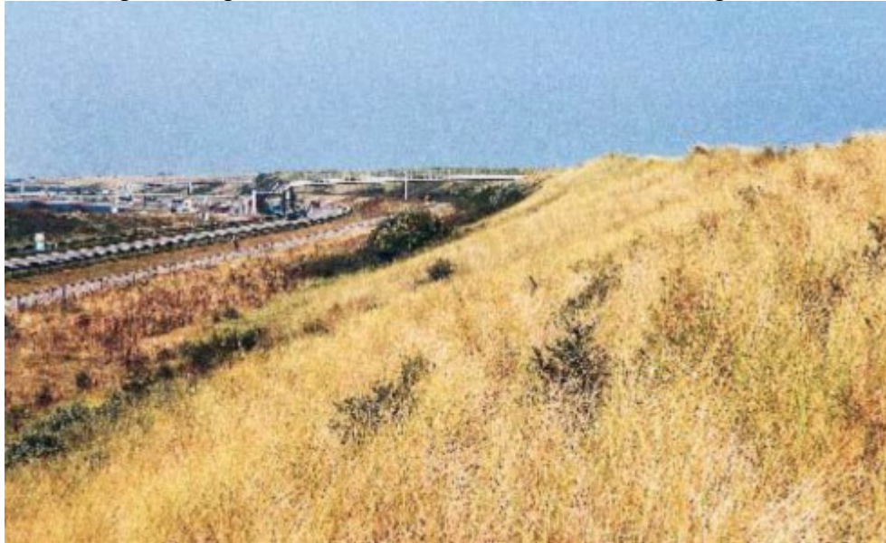
Figuur 3 Zandsuppletie met helm beplant op het binnentalud van de Veersedam, 2000. (Foto NPC).
