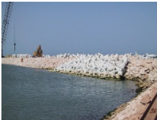
Figuur 1: Losgestorte materialen als oeverbekleding (links), interlock elementen (rechts)
