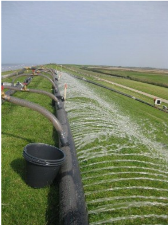
Figuur 1 Wateraanbod bij infiltratie en afschuifproef. Friese Waddenzeedijk nabij de Boonweg.
