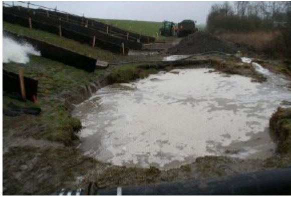
Figuur 1 Jet-erosie bij de overgang van een talud naar horizontaal.
