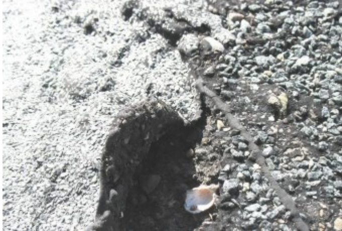
Figuur 18 Onvoldoende hechting: opgekrulde rand van lokale oppervlakbehandeling aangebracht op aangetast oppervlak.
