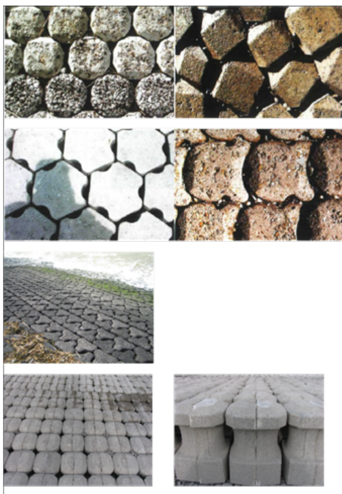
Figuur 2 Zes typen zuilenzetting.
